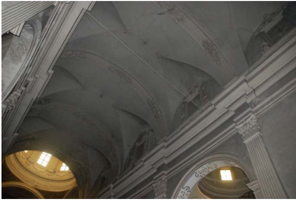
Figura 55. Bóveda de cañón.
