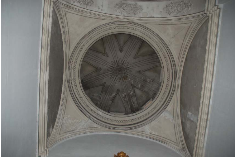
Figura 45. Fotografía del interior de una de las cúpulas de las capillas laterales.
