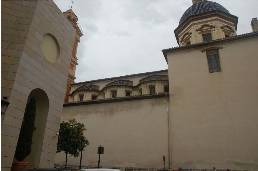
Figura 46. Fotografía del alzado Noroeste de la Iglesia.
