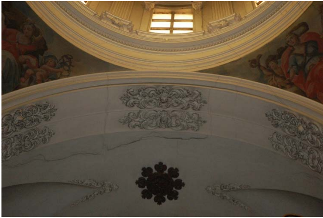
Figura 40. Fotografía de uno de los arcos torales de la cúpula principal.
