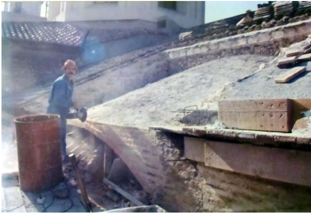
Figura 32. Fotografía de la zona reparada de la cubierta encontrada en el Archivo Parroquial de la Iglesia de San miguel y San Sebastián.
