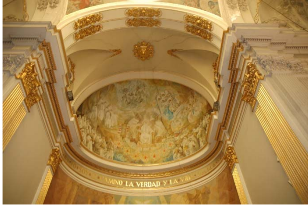
Figura 86. Bóveda de nicho
