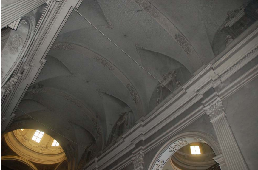
Figura 42. Fotografía de la nave central
