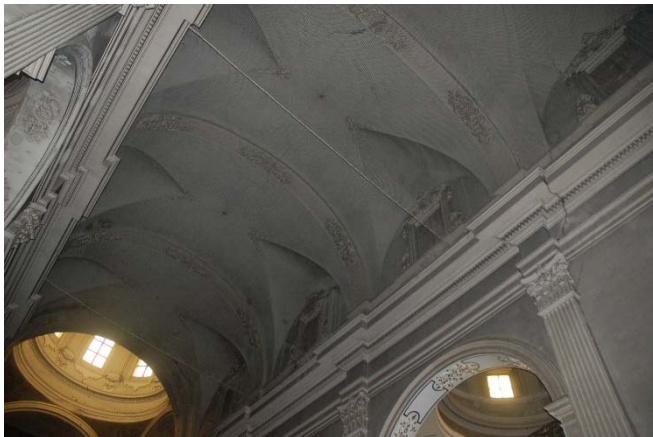
Figura 91. Bóveda de cañón
