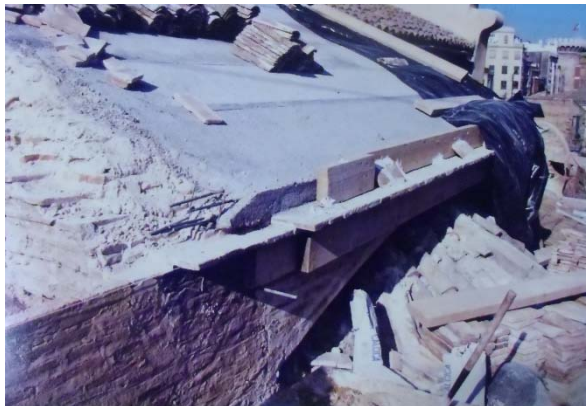
Figura 36. Fotografía de la zona reparada de la cubierta encontrada en el Archivo Parroquial de la Iglesia de San miguel y San Sebastián.
