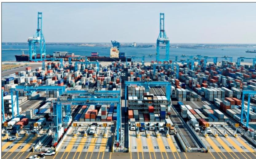
**Figura 116.** Almacenamiento de contenedores – Conexión entre RMG y camión
