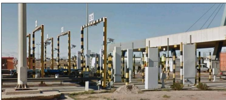
*Fig. 36: Sistema OCR de la puerta terrestre nº1*
