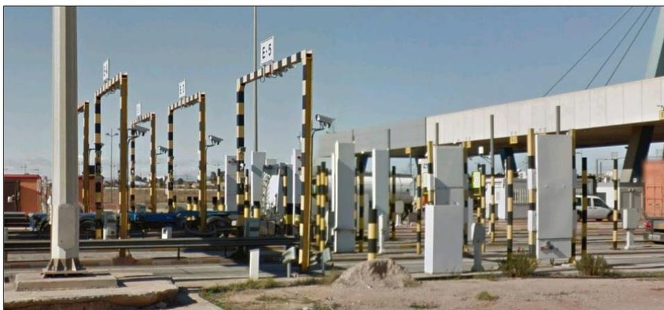
**Figura 23.** Sistema OCR instalado en el acceso de la Terminal NOATUM de Valencia
