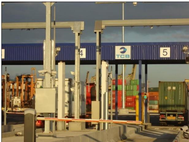
*Fig. 63: Sistema OCR en el acceso a la terminal*
