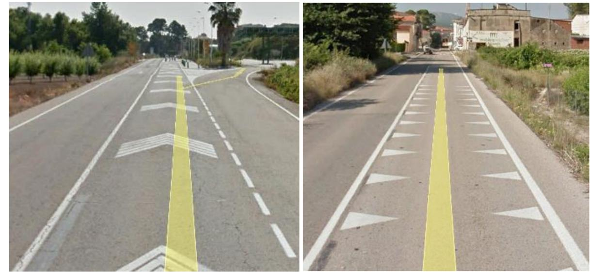
Fig. 20 Ejemplo de Chevron (izquierda) y Dientes de dragón (derecha) en el municipio de Bélgida (valencia). Fuente: Google Earth.
