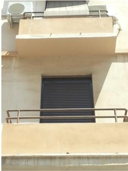
*Ilustración 35. Balcón revestido con un punto de desagüe. Fuente propia*
