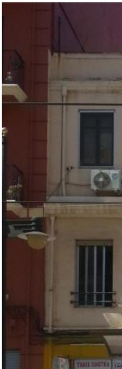
*Ilustración 33. Junta de dilatación entre 2 edificios. Fuente propia*
