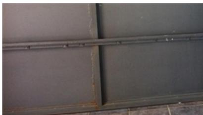
*Ilustración 59. Corrosión por aireación diferencial. Fuente de internet (google corrosión por aireación diferencial)-22/06/2015 19:33*
