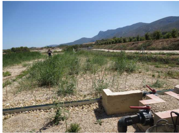
Ilustración 2824. Humedal Horizontal 1 - Septiembre 2014 (Entrada)
