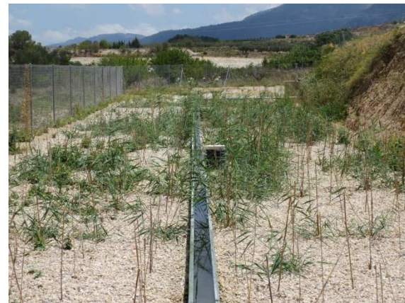
Ilustración 21. Humedal Vertical Junio 2014- 2
