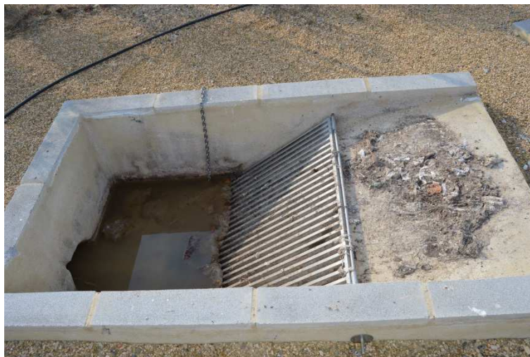
Ilustración 10. Canal de desbaste
