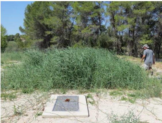
Ilustración 29. Humedal Horizontal 2 - Septiembre 2014 (Salida)
