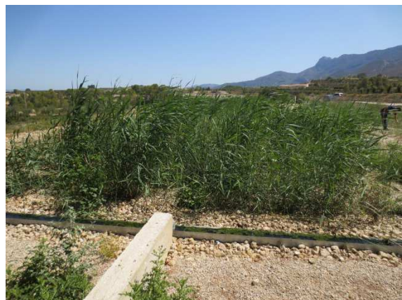
Ilustración 30. Humedal Horizontal 2 - Septiembre 2014 (Entrada)
