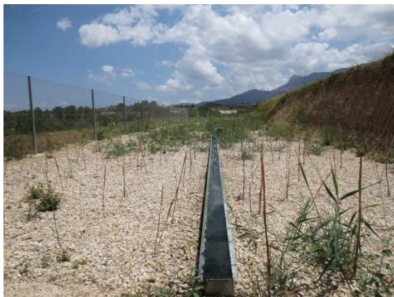
Ilustración 20. Humedal Vertical Junio 2014- 1
