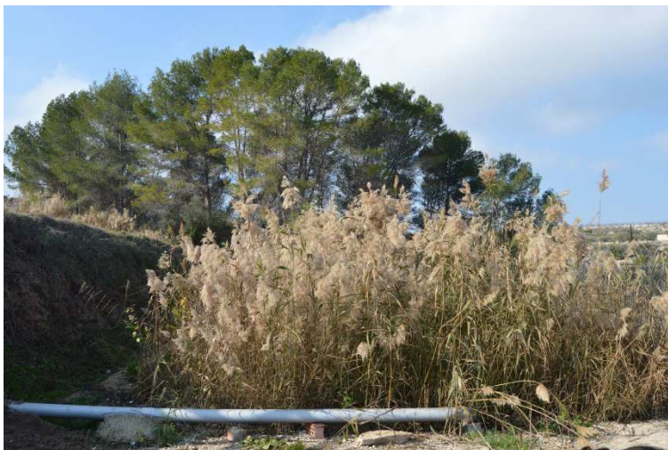
Ilustración 13. Humedal artificial subsuperficial de flujo vertical.
