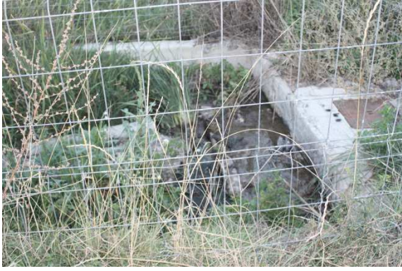
Ilustración 8. Tanque Imhoff EDAR previa.
