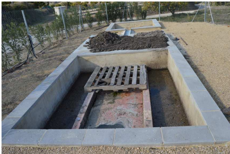
Ilustración 11. Tanques Imhoff en serie
