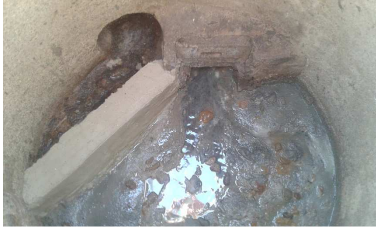
Ilustración 40. Mejora del muro en la arqueta de entrada a la depuradora. Mayo 2015
