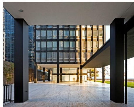
FIG. 10. Marquesina de unión de las torres
