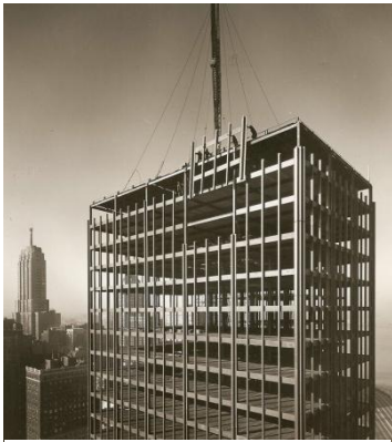
FIG. 13. Fase de construcción
