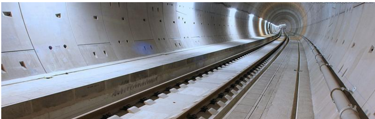
Imagen 7.22: vía en placa sistema OBB-POOR instalado en túnel (Austria). Fuente: http://www.railone.com
