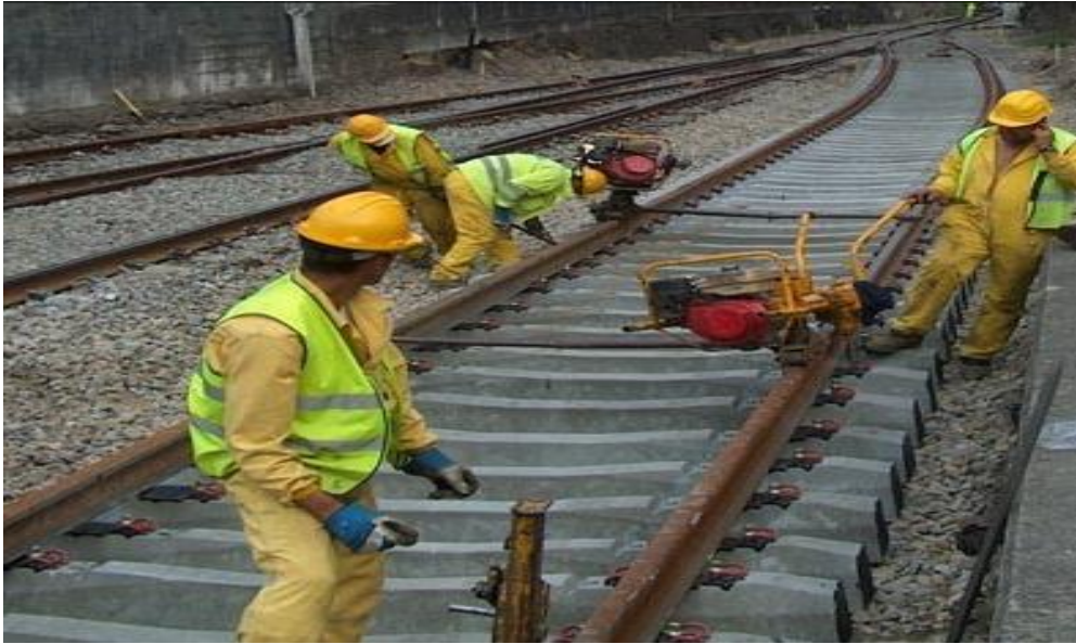
Imagen 7.19: trabajos de renovación de vía en la línea de ancho convencional Zafra-Huelva. Fuente: http://www.ugofe.com.ar
