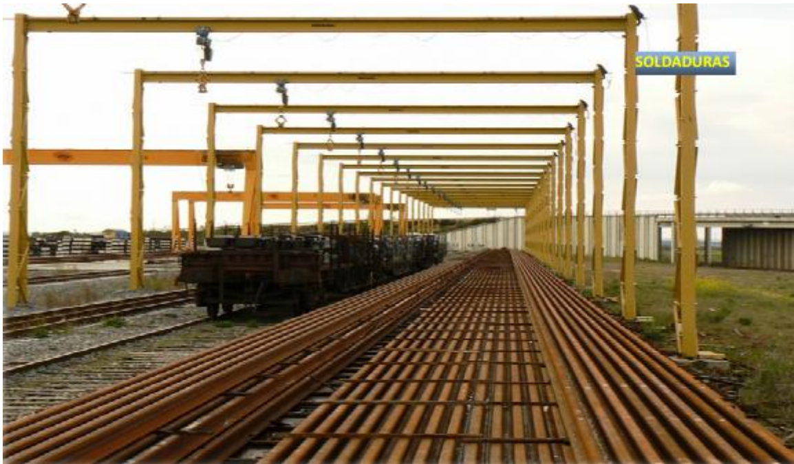
Imagen 7.15: Acopio de carriles y pórticos preparados para su carga a los trenes de trabajo. Fuente: http://www.feve.es
