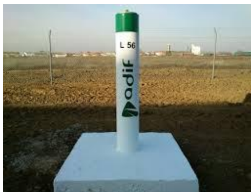
Imagen 7.10: Hito topográfico construido para obra del ADIF. Fuente: http://www.tusolspain.com
