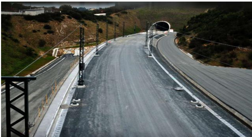
Imagen 7.6: inicio de las obras de montaje de vía sobre la plataforma finalizada. Fuente: http://www.google.com
