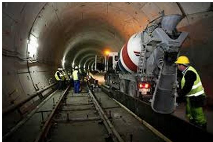
Imagen 7.29: Montaje de vía por separado de forma lineal en túneles. Fuente: http://www.ecomovilidad.net
