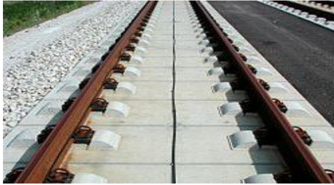
Imagen 7.26: línea de alta velocidad Nuremburg-Ingolstadt, en Alemania, construida de placas prefabricadas BOGL. Fuente: http://es.wikipedia.org
