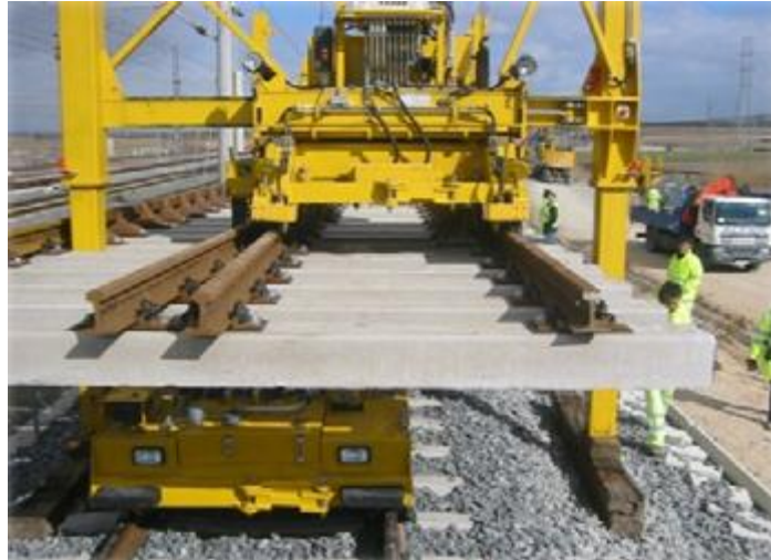
Imagen 7.16: Transportador y pórticos de montaje. Fuente: http://www.feve.es
