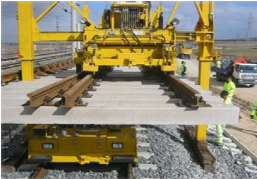
Imagen 7.14: Transportador y pórticos de montaje. Fuente: Nociones Básicas ferroviarias
