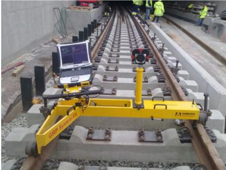
Imagen 7.18: carro de vía se puede utilizar junto con una estación total o un receptor GPS. Fuente: http://www.google.com
