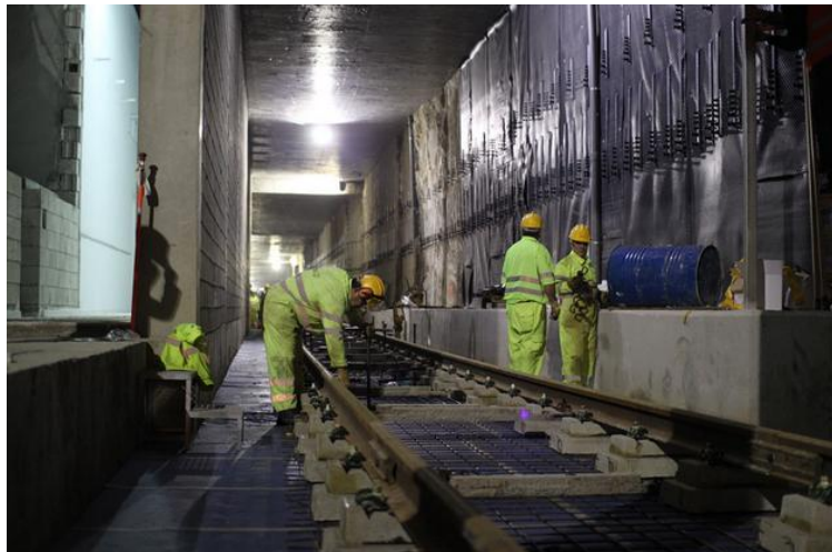
Imagen 7.30: trabajos de hormigonado de la vía en placa. Fuente: http://www.google.com
