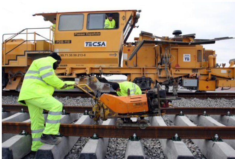
Imagen 7.28: Trabajos topográficos para la alineación y nivelación de la vía. Fuente: http://www.balzola.com
