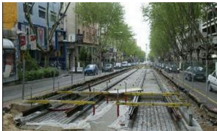
Imagen 7.27: Obras de construcción del tranvía de Jaén. Fuente: http://www.google.com
