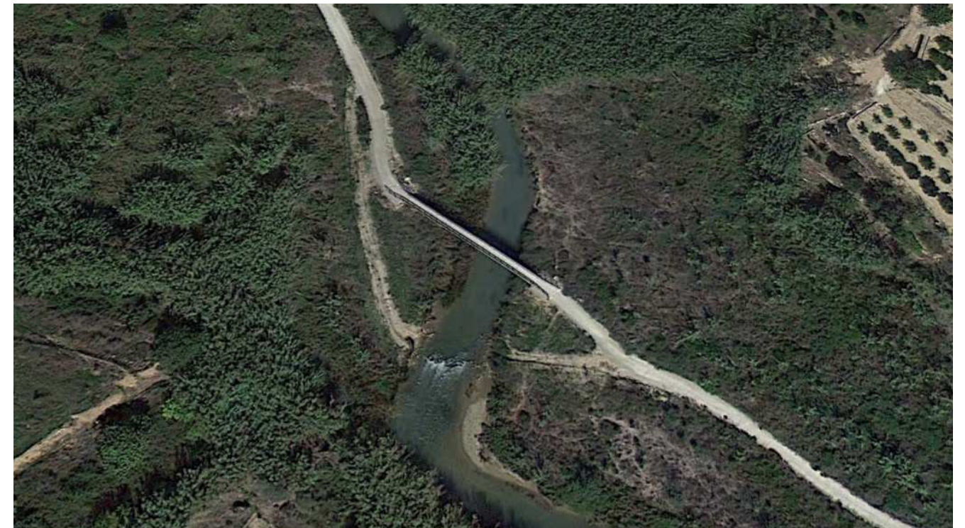
Figura 6. Pasarela sobre el río Turia justo aguas arriba de la cerrada. Google Earth.
