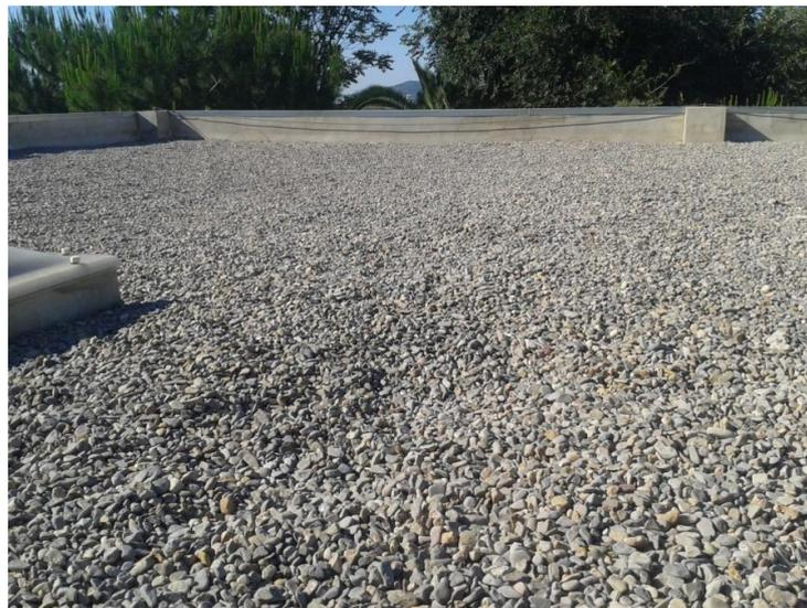
Figura 24: Cubierta de grava
