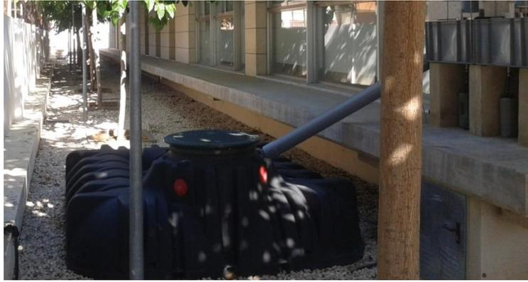
Figura 28: Depósito de agua de riego
