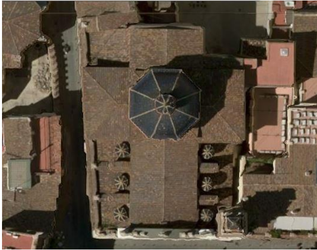
Vista planta de cubiertas. (Fotografía: Bing Maps)
