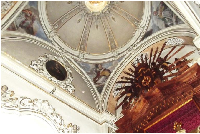
Figura 16. Arcos formeros y fajones de las capillas laterales
