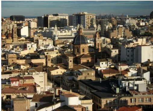
Vista general de la cubierta y el entorno. Fotografía: Wikipedia
