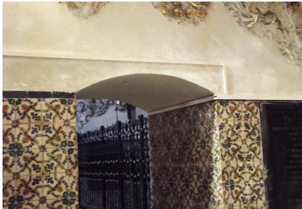
Figura 15. Hueco de paso en contrafuertes de capillas laterales.
