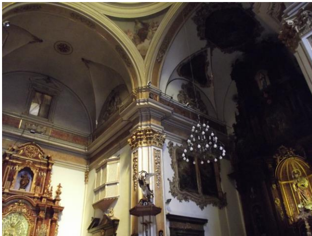
Encuentro entre nave central y el crucero (Fotografía: Bárbara Moreno)
