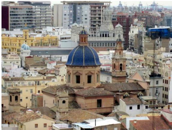
Vista general de las cubiertas. (Fotografía: J. Díez Arnal)
