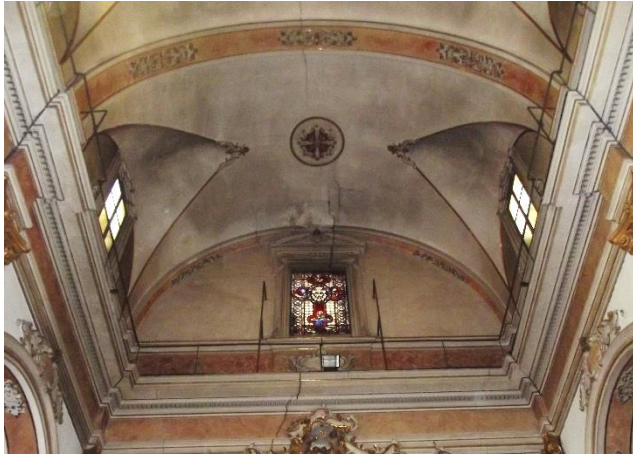
Figura 17. Arcos formeros y fajones de la nave central
