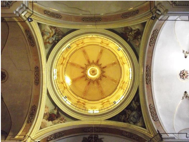
Figura 18. Arcos torales de sostén de la cúpula central.
