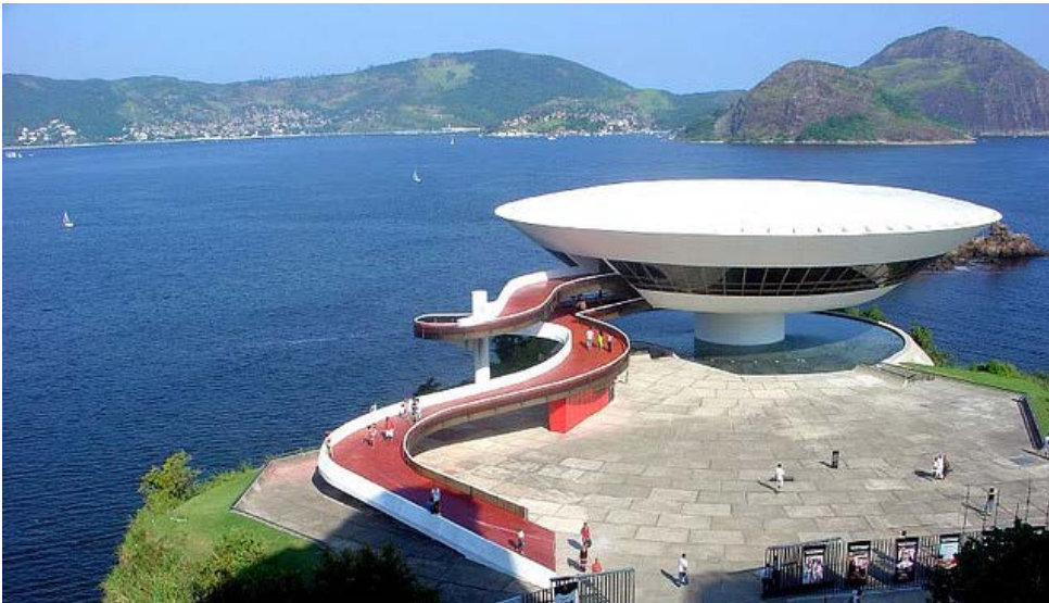
Imagen 2.25 Vista de la plaza, en relación con el entorno y con el MAC. La lámina de agua simula que el edificio flota sobre la propia bahía
