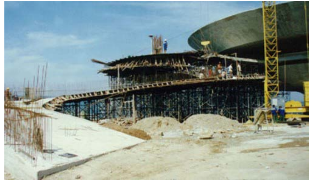
Imagen 2.35 Construcción de la rampa de acceso
