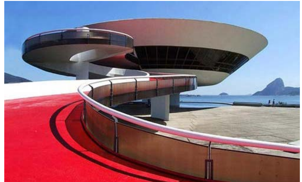
Imagen 2.29 Vista de la rampa a nivel de peatón desde el inicio. Destaca el color rojo frente al blanco del resto del MAC
