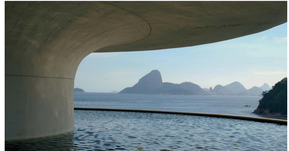
Imagen 2.24 Museo de Arte Contemporáneo de Niterói, vista del soporte central y de la parte inferior del primer forjado
