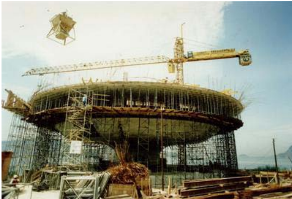
Imagen 2.34 Estructura en construcción
