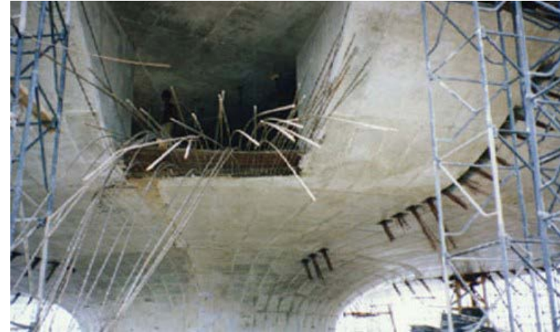
Imagen 2.32 Armadura de espera para el encuentro de la rampa con el acceso al museo
