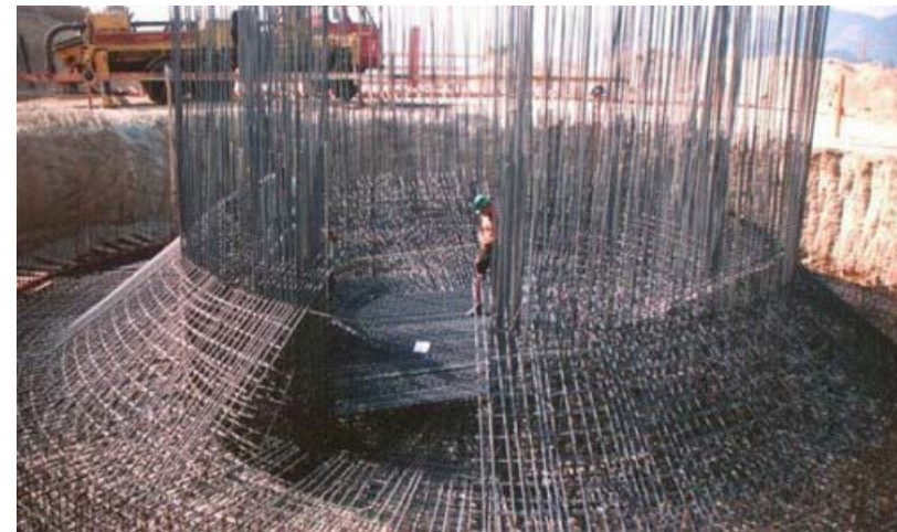
Imagen 2.33 Armadura pasiva de la cimentación y arranque del cilindro central
