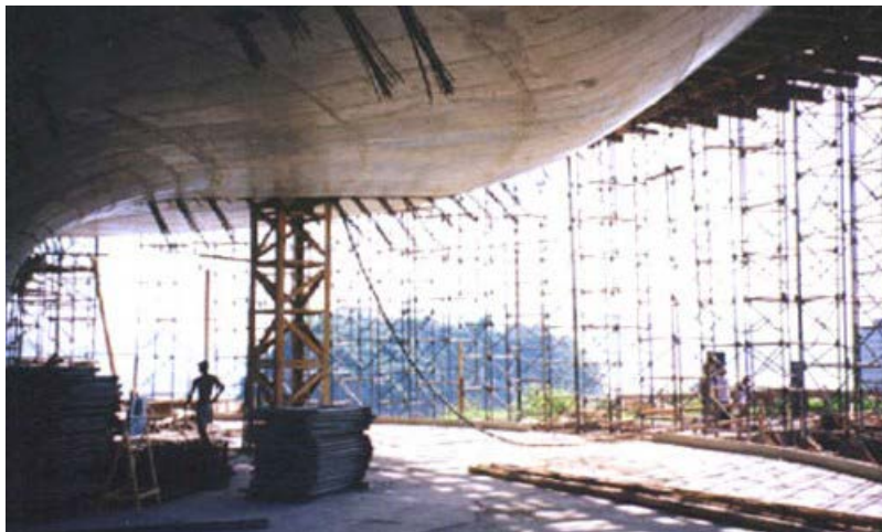
Imagen 2.31 Tensores de la armadura postesada de las vigas pared de planta primera
