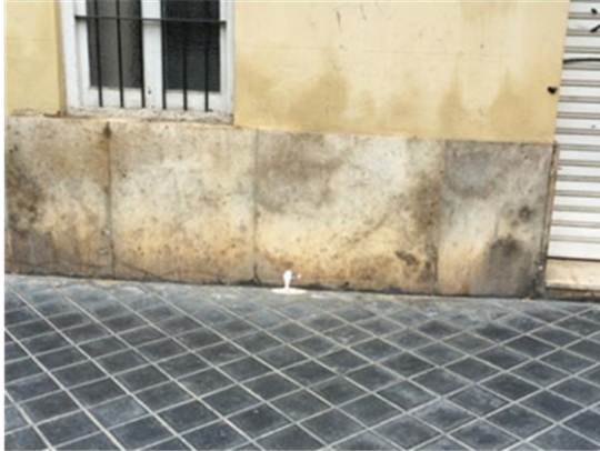
Ilustración 27 .Zócalo en edificio de estudio.
