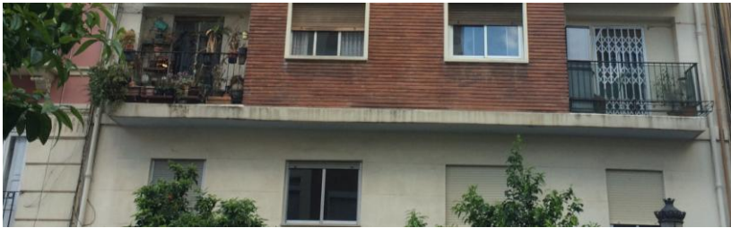
Ilustración 29. Encuentro de fachada con forjado en edificio de estudio.
