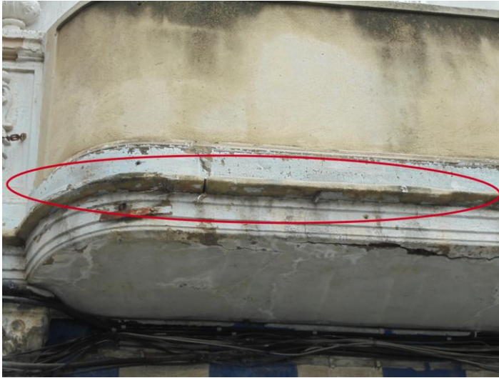
Ilustración 44. Erosión atmosférica. Fuente Guillem Aparicio Albert Mayo 2015
