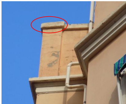
Ilustración 50 . Erosión mecánica causada por la acción del viento. Fuente Luis Navarro
