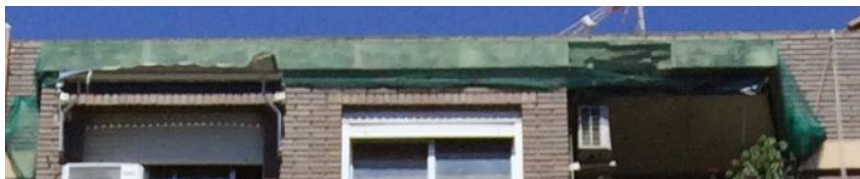
Ilustración 36. Ejemplo de cornisa en edificio de estudio. Abril 2015.
