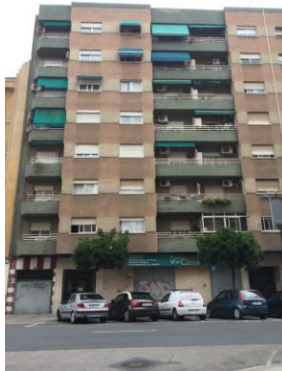
Ilustración 26. Fachada revestida con mortero monocapa. Fuente propia
