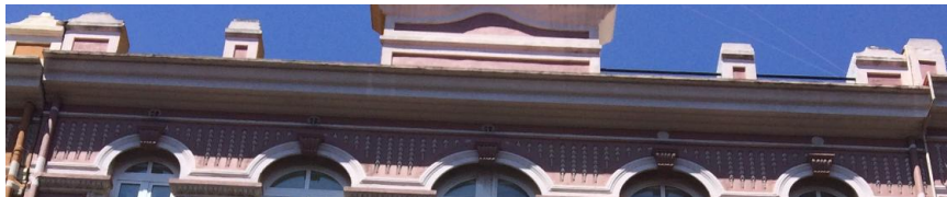
Ilustración 35. Ejemplo de cornisa con canalón en edificio de estudio. Abril 2015.
