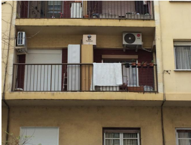
Ilustración 32 .Voladizo en edificio de estudio. Abril 2015.
