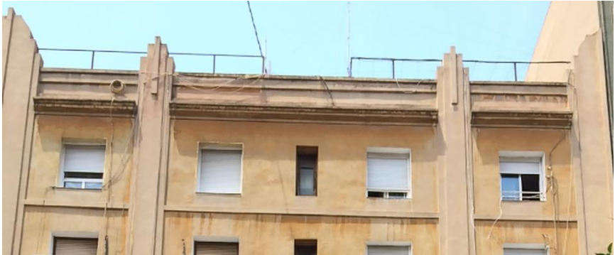
Ilustración 37. Ejemplo de antepecho en edificio de estudio.
