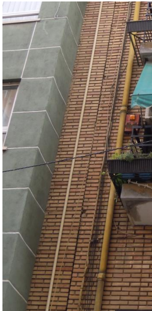
Ilustración 31. Junta de dilatación entre 2 edificios objeto de estudio. Abril 2015.
