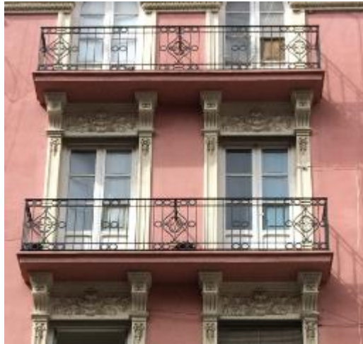
Ilustración 34. Balcón con barandilla perimetral en edificio de estudio.
