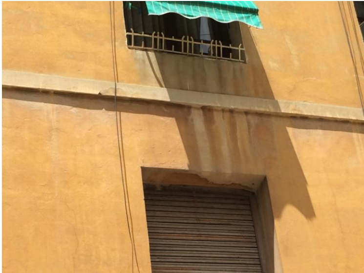
Ilustración 43. Suciedad por lavado diferencial. Fuente propia. Mayo 2015
