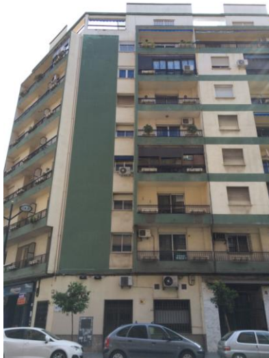
Ilustración 25. Fachada enfoscada. Fuente propia Marzo 2015
