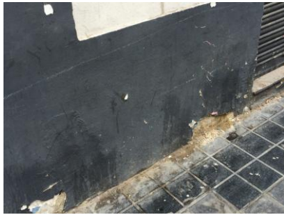
Ilustración 55 Lesión causada mayormente por diferentes animales, Fuente propia Abril 2015
