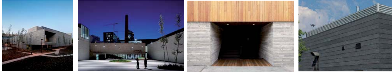
Hormigón visto de encofrado horizontal
