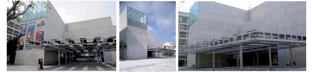
Pérgola metálica como conexión entre la nave y el nuevo edificio.
