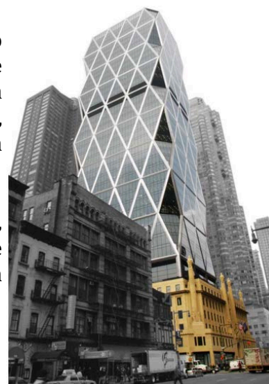
Figura 5: Imagen exterior del edificio.
