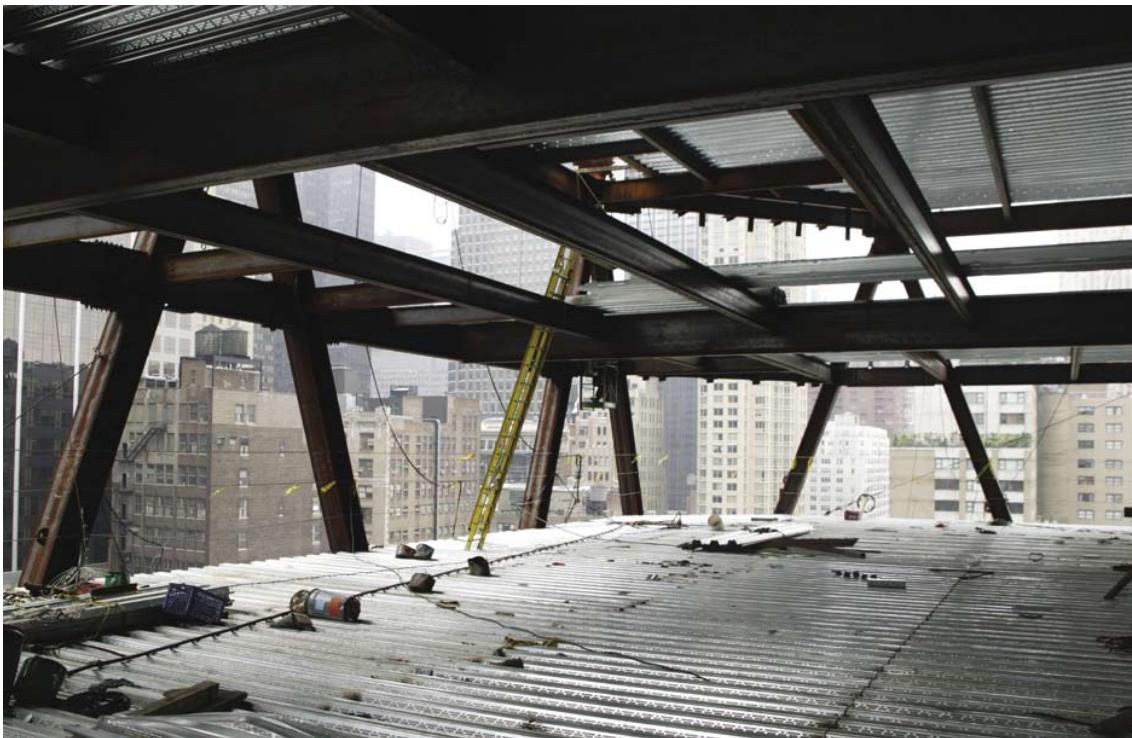
Figura 33: Amplias luces se extienden dentro del interior, pudiendo llegar a ser de 12 metros (40 ft) o más. Fuente: Ficeto, M. Diagrid Framing system lifts historic building into skyline Hearst Tower
