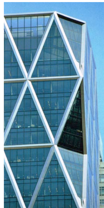
Figura 60: Diagonales vistas en fachada. Fuente: Meyer Boake, T. (2014). Diagrid structures: systems, connections, details .
