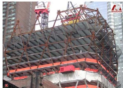
Figura 65: Imágenes donde se aprecia la modulación del forjado, cantidad de correas y geometrías generadas. Fuente: internet. Mountain Enterprises Web.
