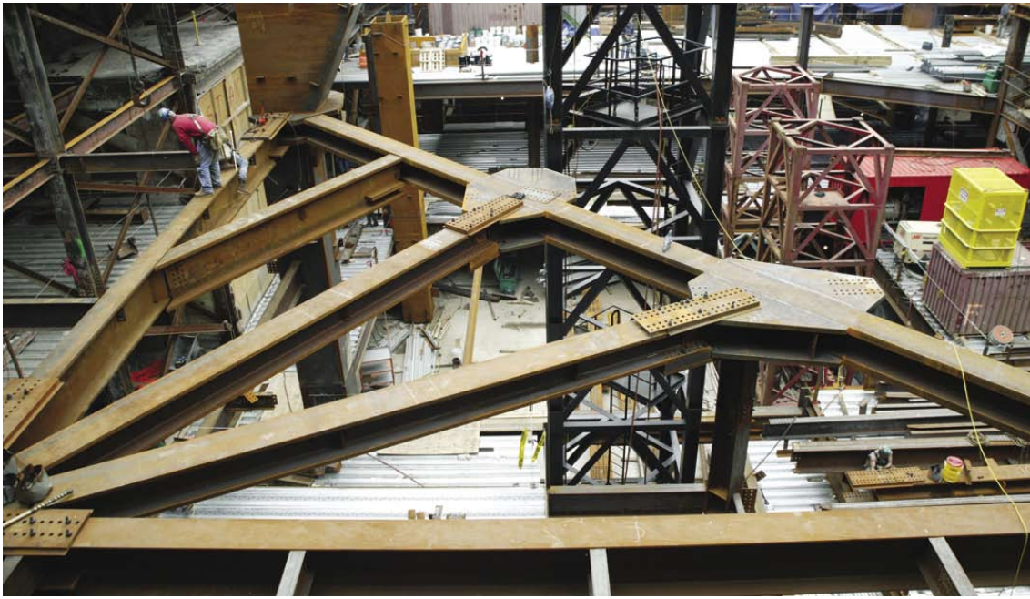
Figura30: Estructura por debajo del atrio, arriostra lateralmente los grandes pilares y diagonales. Fuente: Ficeto, M. Diagrid Framing system lifts historic building into skyline Hearst Tower.
