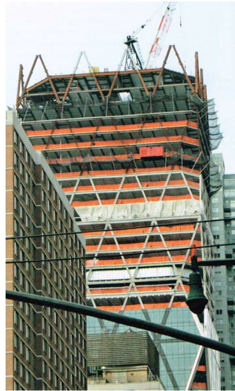
Figura 58: Montaje, instalación de protección contra incendios y el revestimiento en curso de construcción. Fuente: Meyer Boake, T. (2014). Diagrid structures: systems, connections, details
