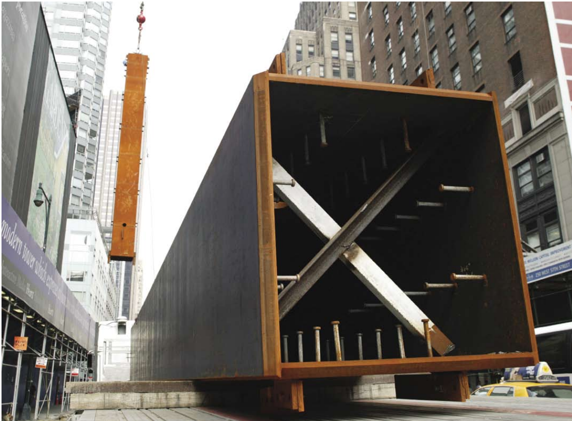
Figura 28: Los grandes “cajones” de los pilares de 1,25 m 2 (44in-square box columns) se ensamblaron con pletinas de acero laminado de 10,6 cm (4in) de espesor. Fuente: Ficeto, M. Diagrid Framing system lifts historic building into skyline Hearst Tower
