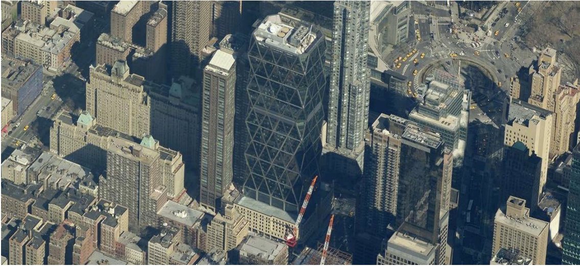
Figura 36: Fachadas Sur y Este. Fuente: Bing maps.
