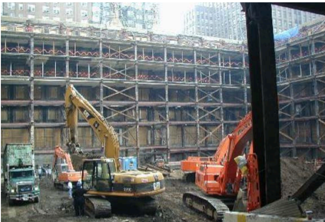
Figura 25: Estructura que sustentó la fachada preexistente. Fuente: Rahimian, A., Eilon, Y. (2008) "Hearst Headquarters: Innovation and Heritage in Harmony." CTBUG 8th World Congress.
