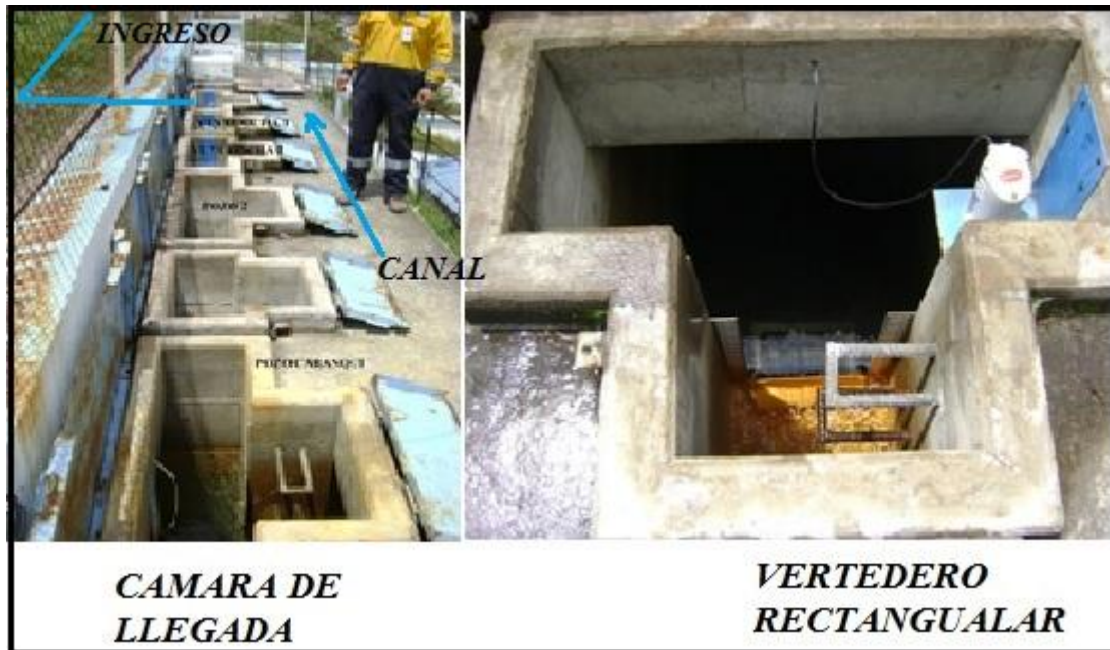
Figura 18 Vista general de la cámara de llegada y del vertedero.
