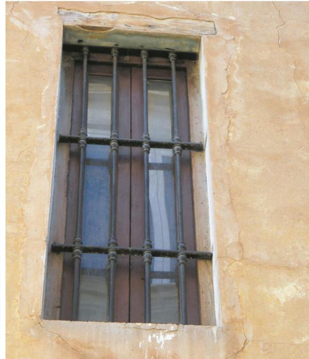
**Ilustración 74:** Rejería metálica enrasada
