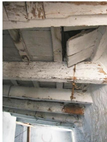
**Ilustración 90:** Fallo de entabicado que conforman la cubierta Fuente: Propia
