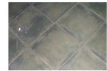
Baldosa hidráulica dim. 20x20
