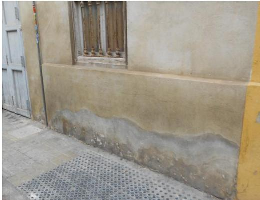
*Ilustración 28. Humedad por capilaridad. 2015. Fuente: Elaboración propia*
