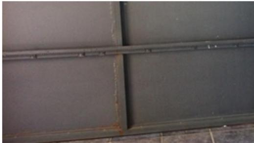
*Ilustración 67 Corrosión por aireación diferencial. Abril 2015. Fuente: Internet (Google: corrosión por aireación diferencial)*
