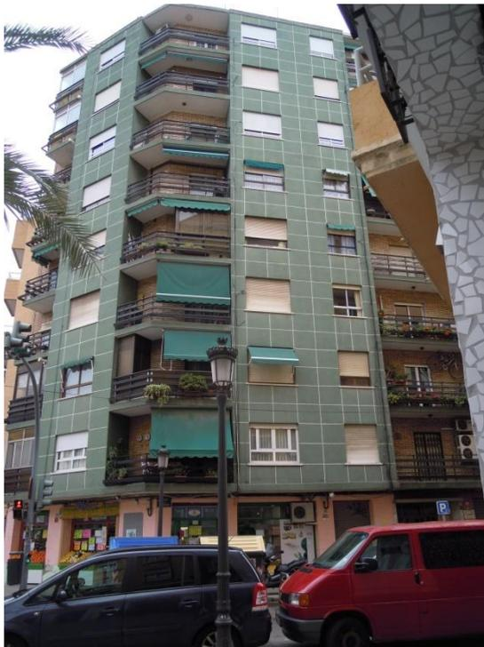
*Ilustración 35. Fotografía fachada revestida con mortero monocapa.*
