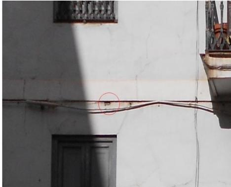
*Ilustración 20. Desconchado de revestimiento. 2015.*
