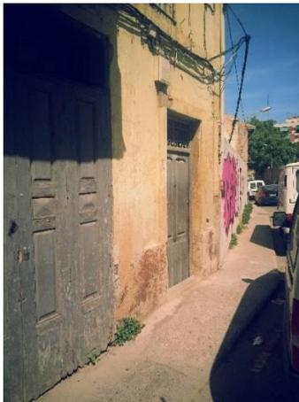
*Ilustración 70. Vegetación en el arranque de la fachada.*
