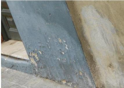
*Ilustración 19. Abombamiento de pintura. 2015.*
