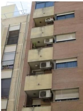
*Ilustración 53. Ensuciamiento por deposición.*
