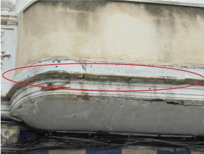
*Ilustración 56. Erosión atmosférica.*
