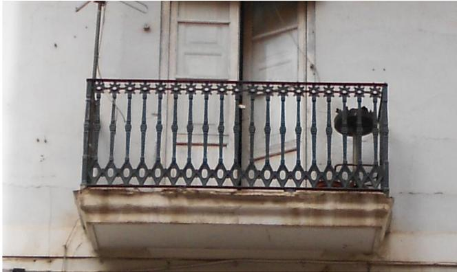
*Ilustración 25. Pérdida de sección en moldura de balcones. 2015. Fuente: Elaboración propia*
