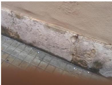
*Ilustración 72. Erosión del zócalo del edificio.*
