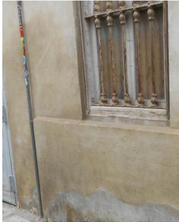
*Ilustración 23. Oxidación de rejas. 2015. Fuente: Elaboración propia*
