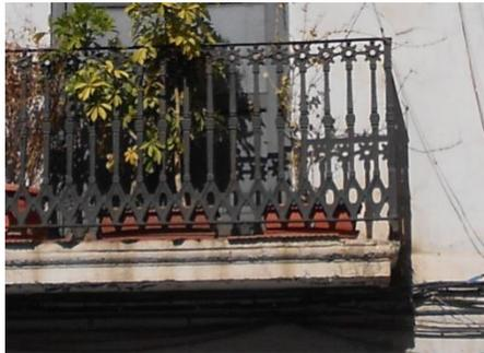
*Ilustración 24. Oxidación de barandillas. 2015. Fuente: Elaboración propia*
