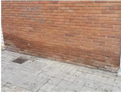
*Ilustración 71. Erosión parte baja de ladrillo cara vista.*
