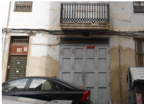
*Ilustración 15. Fotografía carpintería de madera y cerrajería de forja.2015.*
