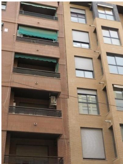
*Ilustración 39. Junta de dilatación entre 2 edificios objeto de estudio.
