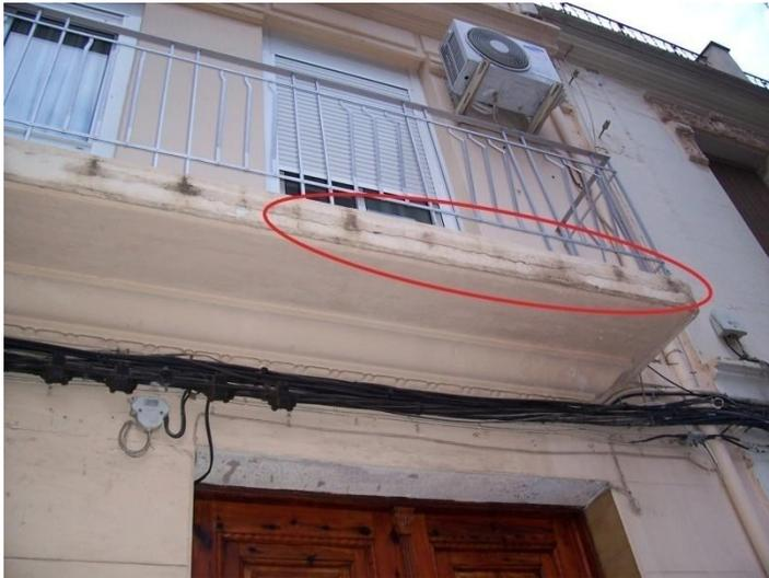
*Ilustración 60. Fisura en balcón.*
