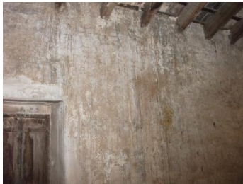
Figura 96. Manchas por filtración de agua y cuarteado del revestimiento de paramentos en planta 2ª. 2015. Fuente propia
