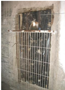
Figura 80. Puerta de entrada al Almacén 5 situada en planta 2ª. 2015. Fuente propia
