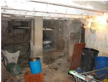
Figura 26. Almacén 2 situado en planta baja. 2015. Fuente propia
