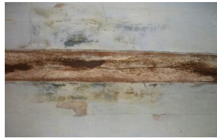
Figura 104. Manchas de humedad en vigueta de madera y deterioros en el revestimiento de las bovedillas del forjado situado en planta baja. 2015. Fuente propia
