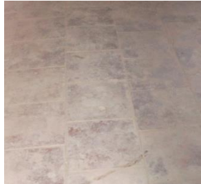
Figura 56. Baldosas de terracota a matajuntas. 2015. Fuente propia
