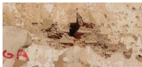
Figura 86. Pérdida de material en fachada este (muro de tapia). 2015. Fuente propia
