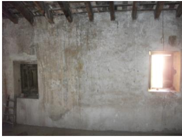
Figura 95. Manchas por filtración de agua en paramentos de la planta 2ª. 2015. Fuente propia
