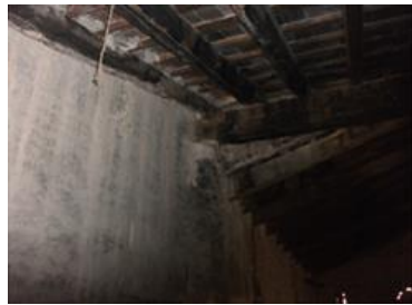
Figura 109. Viguetas afectadas por pudrición y carbonización. 2015. Fuente propia
