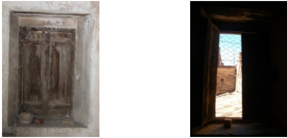
Figura 74. Ventanas de doble hoja en la planta 2ª de la fachada sur, medianera a edificio colindante. 2015. Fuente propia
