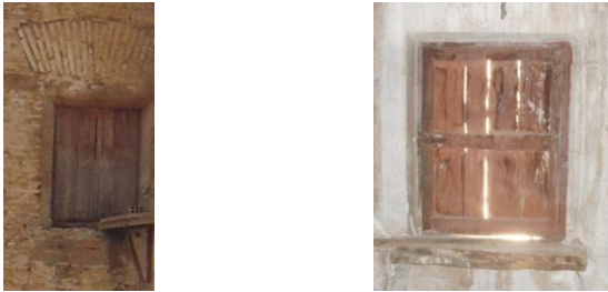
Figura 65. Vista exterior e interior de la ventana situada en la planta 2ª de la fachada norte. 2015. Fuente propia
