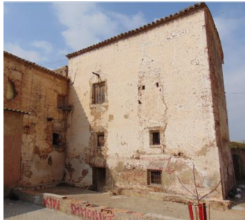
Figura 18. Fachada este del volumen 1. 2015. Fuente propia
