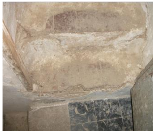
Figura 57. Diferentes solados: Terrazo y rasillas cerámicas en las escaleras; baldosa hidráulica Tipo 1 en el descansillo. 2015. Fuente propia
