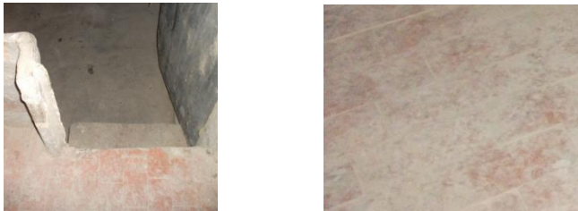
Figura 54. Pavimento continuo y rasillas cerámicas a matajuntas en planta 2ª. 2015. Fuente propia
