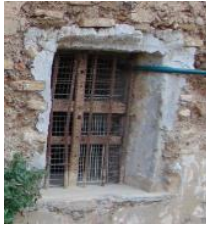
Figura 71. Ventana situada en la planta baja de la fachada oeste del volumen 1. 2015. Fuente propia
