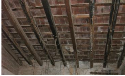
Figura 108. Deterioro de viguetas debido a humedad por filtración y carbonización por fogatas. 2015. Fuente propia
