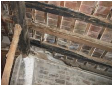
Figura 109. Viguetas afectadas por pudrición y carbonización. 2015. Fuente propia
