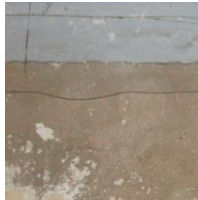
Figura 52. Acabados del vestíbulo. 2015. Fuente propia
