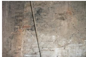
Figura 102. Ensuciamiento de paramento con hollín situado en planta 2ª. 2015. Fuente propia
