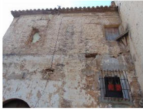
Figura 93. Cableado de instalaciones eléctricas. 2015. Fuente propia
