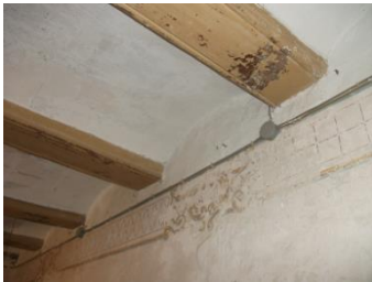
Figura 39. Forjado de revoltones del Salón en planta 1ª. 2015. Fuente propia
