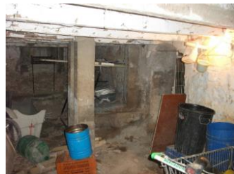
Pilar de refuerzo en centro de vano de viguetas de forjado de rasillas
