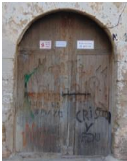
Figura 61. Portón de acceso principal. 2015. Fuente propia
