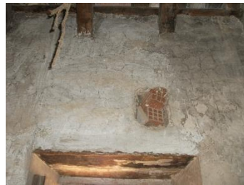
Figura 96. Manchas por filtración de agua y cuarteado del revestimiento de paramentos en planta 2ª. 2015. Fuente propia
