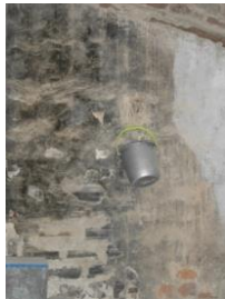
Figura 102. Ensuciamiento de paramento con hollín situado en planta 2ª. 2015. Fuente propia
