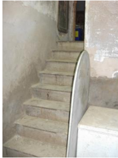
Figura 58. Escaleras de comunicación con planta 1ª. 2015. Fuente propia
