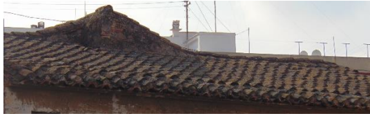
Figura 114. Vegetación en cubierta de teja árabe. 2015. Fuente propia
