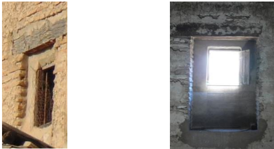
Figura 66. Vista exterior e interior de la ventana situada en la planta 2ª de la fachada este, medianera a edificio colindante. 2015. Fuente propia
