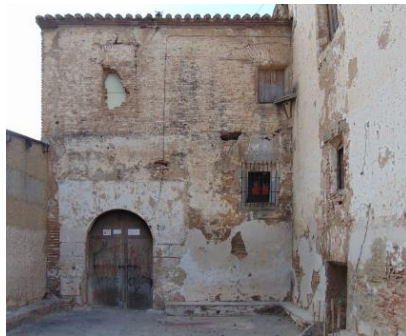
Figura 22. Fachada norte del volumen 2. 2015. Fuente propia
