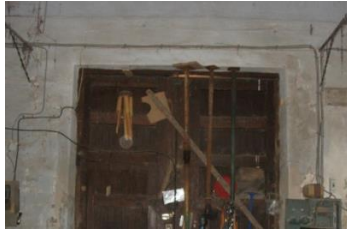
Figura 62. Puerta de acceso principal desde el interior. 2015. Fuente propia
