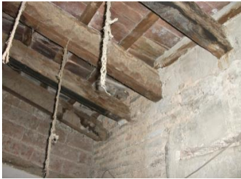
Figura 108. Deterioro de viguetas debido a humedad por filtración y carbonización por fogatas. 2015. Fuente propia
