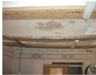
Figura 39. Forjado de revoltones del Salón en planta 1ª. 2015. Fuente propia
