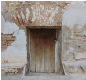
Figura 67. Puerta de acceso secundaria situada en la planta baja de la fachada este del volumen 1. 2015. Fuente propia
