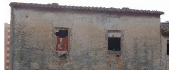
Ejemplo de ennegrecimiento en la fachada oeste
