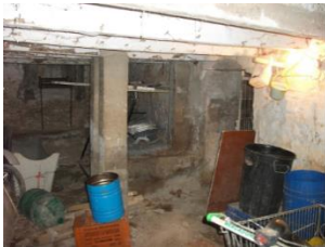
Figura 107. Pilar de refuerzo en centro de vano de viguetas de forjado de rasillas y forjado de revoltones situados en planta baja. 2015. Fuente propia
