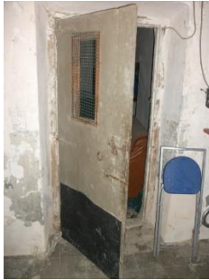
Figura 76. Puerta de madera del Salón en planta 1ª. 2015. Fuente propia
