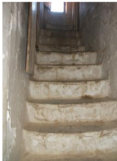
Figura 59. Escaleras de comunicación con planta 2ª. 2015. Fuente propia
