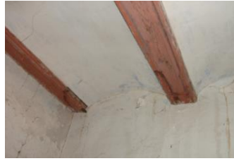
Figura 103. Vigueta de madera afectada por la humedad con presencia de organismos xilófagos, situado en el forjado de revoltones de la Sala de estar en planta 1ª. 2015. Fuente propia
