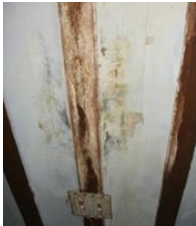
Figura 104. Manchas de humedad en vigueta de madera y deterioros en el revestimiento de las bovedillas del forjado situado en planta baja. 2015. Fuente propia
