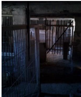
Figura 27. Almacén 1 situado en planta baja. 2015. Fuente propia
