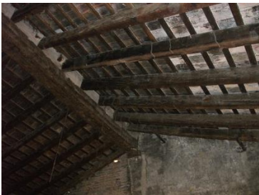
Figura 110. Deterioros de viguetas debido a humedad por filtración. 2015. Fuente propia
