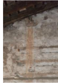
Figura 95. Manchas por filtración de agua en paramentos de la planta 2ª. 2015. Fuente propia
