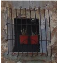
Figura 63. Ventana situada en la planta 1ª de la fachada norte (protección con manta) 2015. Fuente propia
