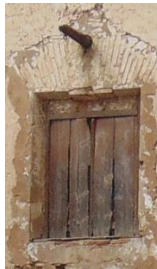
Figura 70. Ventana situada en la planta 2ª de la fachada este del volumen 1. 2015. Fuente propia
