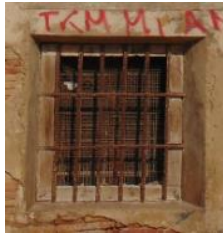
Figura 68. Ventana situada en la planta baja de la fachada este del volumen 1. 2015. Fuente propia
