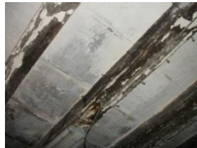
Figura 41. Forjado de entablado continuo en planta 1ª. 2015. Fuente propia
