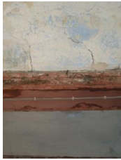
Figura 103. Vigueta de madera afectada por la humedad con presencia de organismos xilófagos, situado en el forjado de revoltones de la Sala de estar en planta 1ª. 2015. Fuente propia
