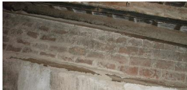
Figura 99. Mohos en la parte superior de paramento en planta 2ª. 2015. Fuente propia
