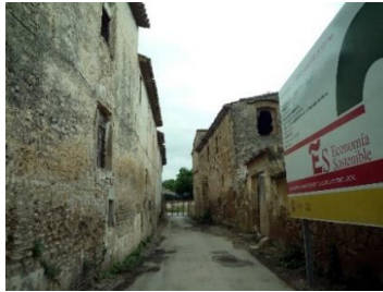
Figura 17. Vista desde el Camino de La Alquería del Moro. A la derecha se encuentra la alquería principal. 2010. Autor: José Luis Gil
