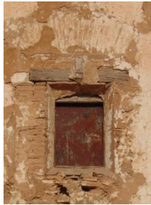
Figura 69. Ventanas situadas en la planta 1ª de la fachada este del volumen 1 (protección con chapa metálica). 2015. Fuente propia
