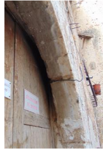
Figura 60. Arco de sillería. 2015. Fuente propia
