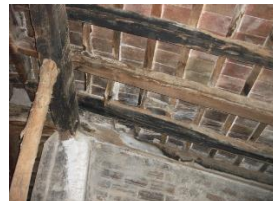
Pudrición y cubrición con Hollín de viguetas
