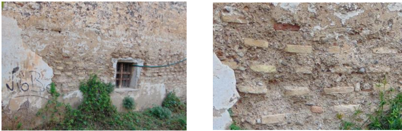
Figura 33. Tapia. Fachada oeste del volumen 1. 2015. Fuente propia
