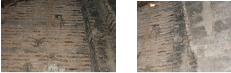
Figura 32. Vista de la fachada este desde el interior de la planta 2ª. Paso de muro de 1 pie a 2 pies de espesor. 2015. Fuente propia
