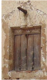
Figura 115. Deterioro de la carpintería de madera. 2015. Fuente propia
