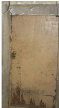
Figura 75. Puerta metálica de entrada al Almacén 4. 2015. Fuente propia
