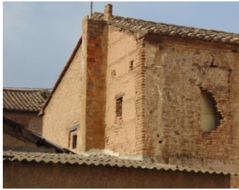
Figura 23. Fachada este del volumen 2, medianera a edificio colindante. 2015. Fuente propia
