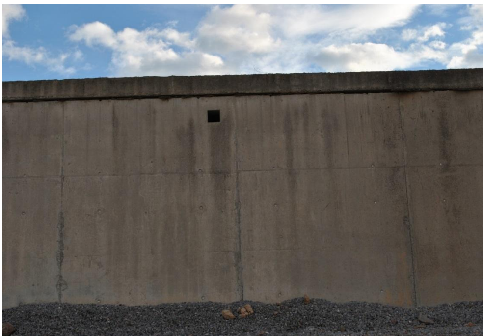
Fig. 10. Respiradero en muros perimetrales
