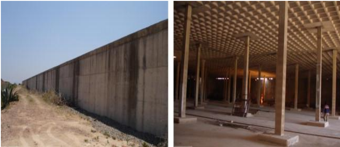
Figs. 8 y 9. Muro 3 e interior del depósito
