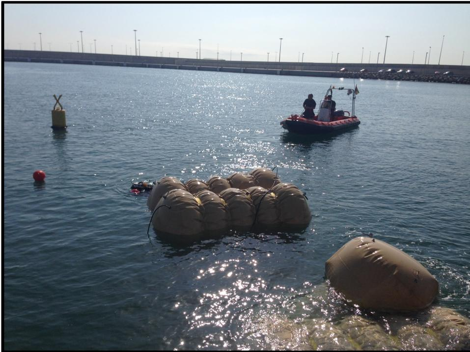
**Imagen 22.** Globos de aire empleados para el traslado de las estructuras.
