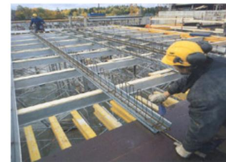
2. Refuerzo de "costillas" se disponen a la separación predeterminada a continuación fijado.
