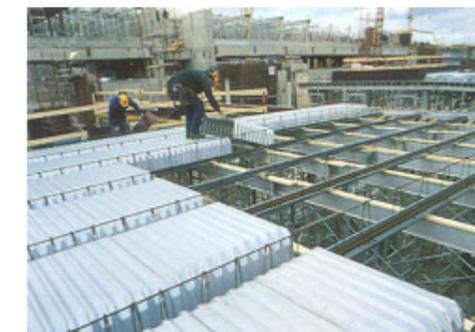
3. Los moldes de encofrado se disponen y encajan en la ranura de la parte inferior de la bandeja. Una superposición de la corrugación del encofrado proporciona un buen sellado contra fugas.
