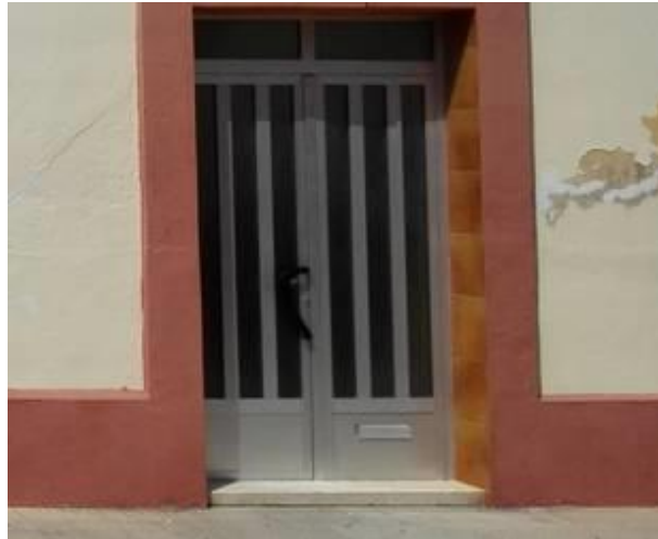
Ilustración 14. Puerta acceso Bloques.
