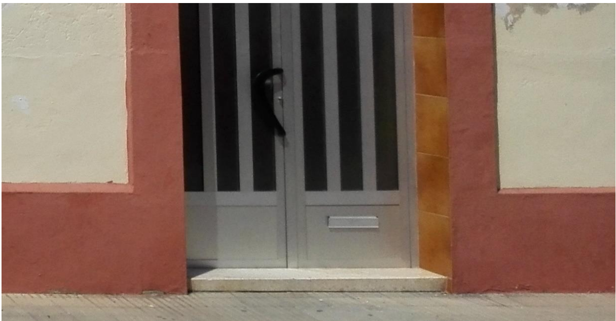
Ilustración 11. Acceso con escalón entradas bloques C/ Perez Valls
