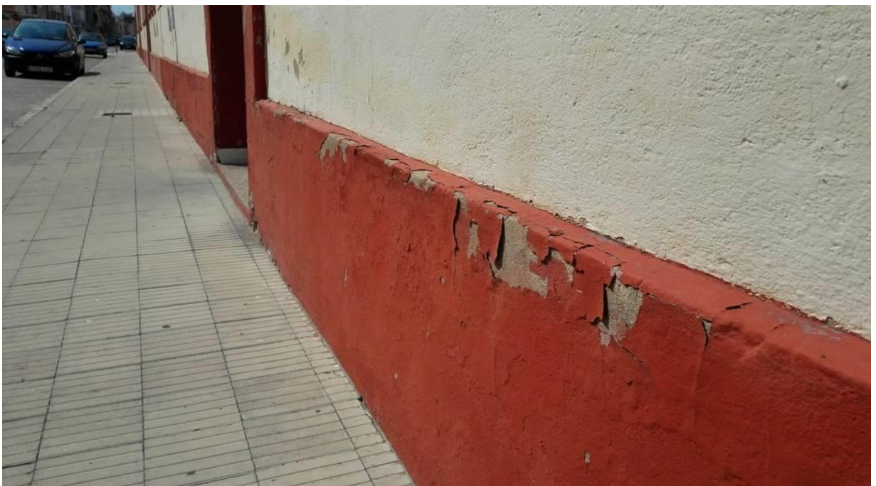
Ilustración 20. Desconchamientos en zócalo perimetral fachadas C/ Pérez Valls y C/ Ausias March
