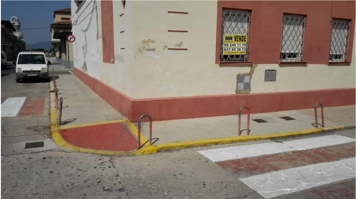
Ilustración 10. Acceso rebajado esquina C/ Perez Valls
