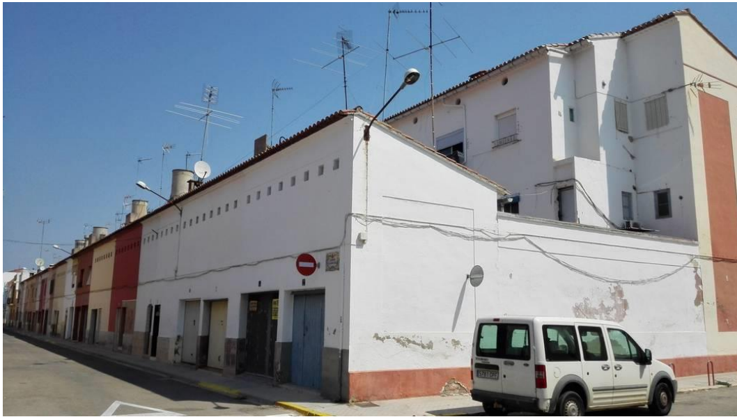
Ilustración 27. Excesivas instalaciones de TV, satélite e internet.
