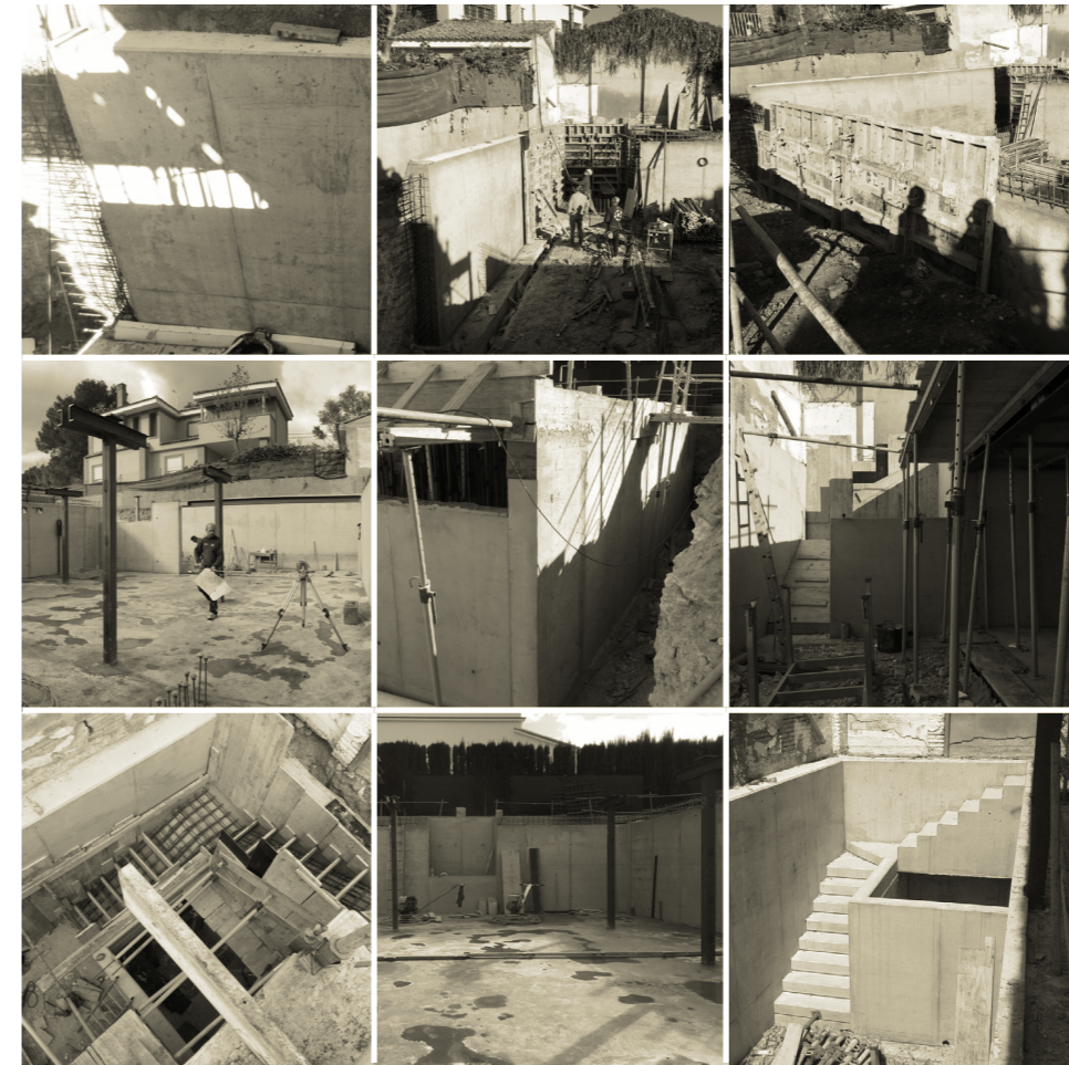
Cimientos y elementos de contención
