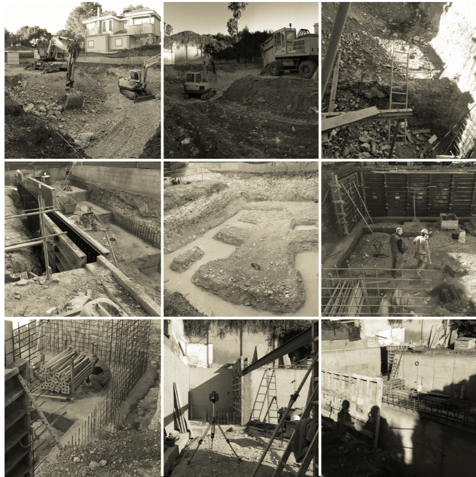
Acondicionamiento del terreno
