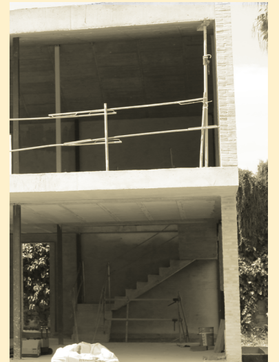
[Fig. 75] Fachadas. Fuente: elaboración propia
