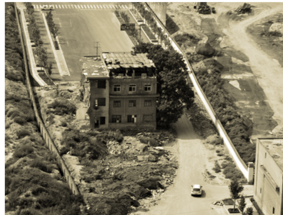
[Fig. 06] Edificio en fase de desmantelamiento: Casa Clavo 04 . Fuente: Plataforma Arquitectura.
