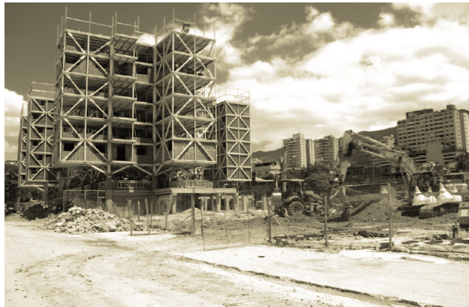
[Fig. 04] Edificio en construcción. Fuente: Plataforma Arquitectura.
