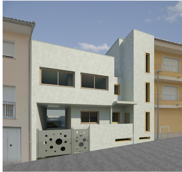
Vista Exterior de la Vivienda Entremedianeras
