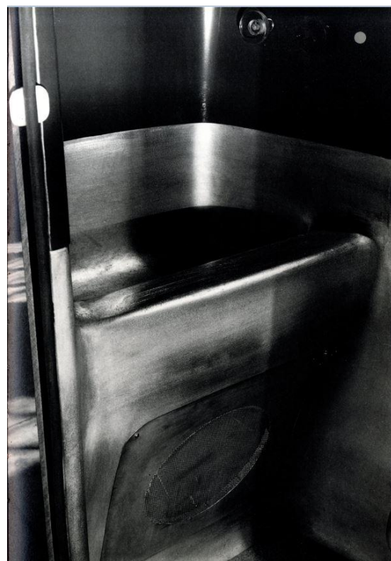
Fig. 20: Sistema ventilación Baño Dymaxion. Fotografía de Hoffmann, B., 1937
