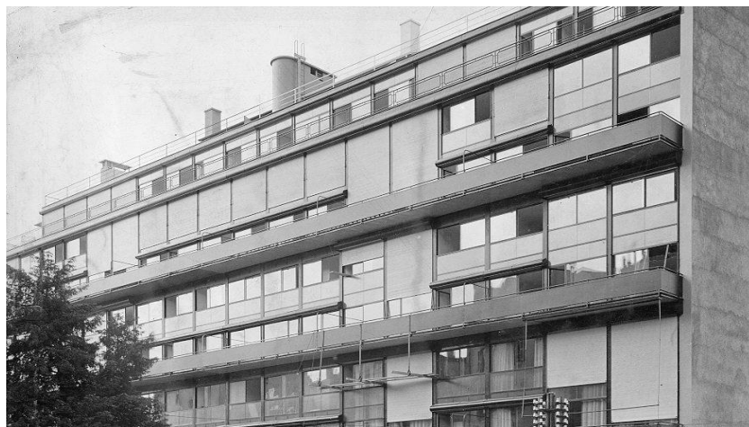
Fig. 12. Fachada del inmueble Clarté. Hans Fingler. Fondation Le Corbusier.
