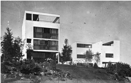
Fig. 03. Fotografía de la intervención de Le Corbusier en la Weissenhofsiedlung. Prototipo Citrohan situado a la izquierda. Fondation Le Corbusier. VEGAP, Barcelona 2005.
