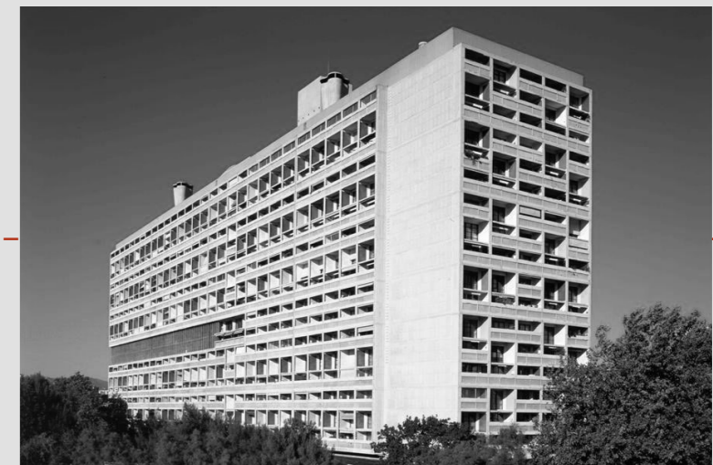
Unité d'Habitation de Marseille (Marsella, 1946-1952)
