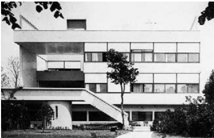
Fig. 02. Fachada posterior. Fondation Le Corbusier.
