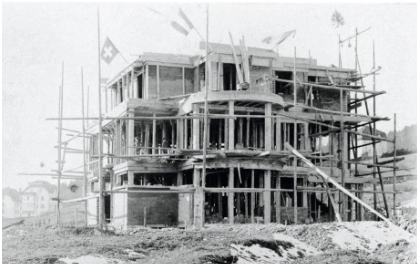
Fig. 09. Construcción de la casa. Fondation Le Corbusier.
