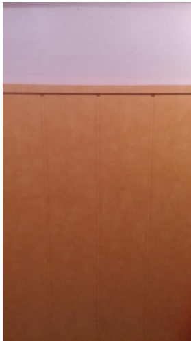
Figura 47: Zócalo de madera en despacho. 2015. Fuente propia.
