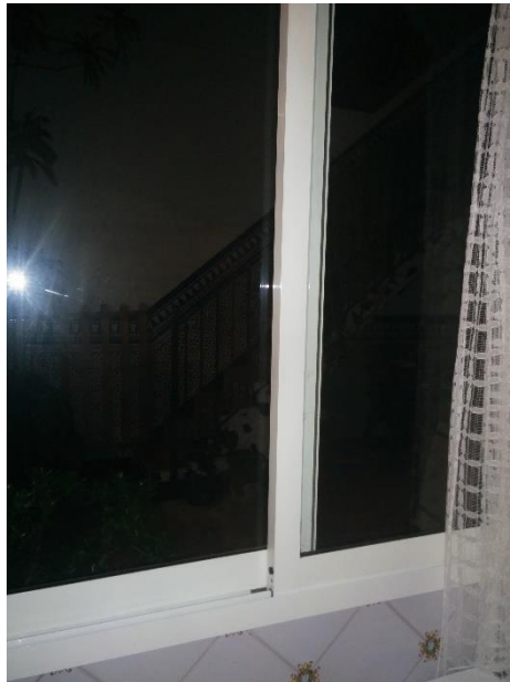
Figura 64: Ventana exterior cocina. 2015. Fuente propia.
