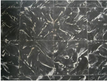
Figura 62: Pavimento acabado baldosa hidráulica. 2015. Fuente propia.
