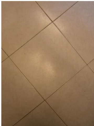
Figura 53: Pavimento acabado suelo cerámico. 2015. Fuente propia.
