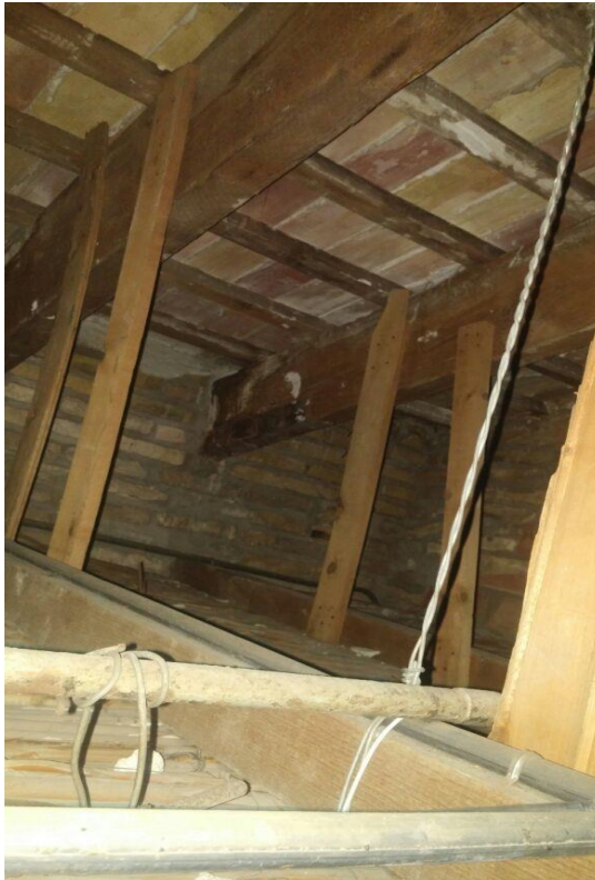
Figura 36: Apoyo Vigas madera, cubierta. 2015.
