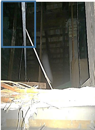
Figura 26: Jácena embebida en medianera. 2015. Fuente propia.
