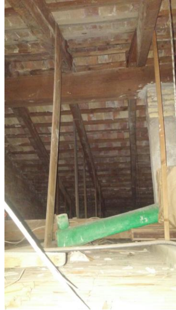
Figura 38: Viguetas y tirantes cubiertos. 2015. Fuente propia.
