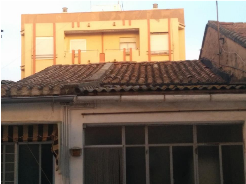
Figura 39: Cubierta de teja. 2015. Fuente propia.
