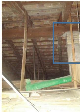
Figura 25: Apoyo jácena del pórtico sobre pilar. 2015. Fuente propia.
