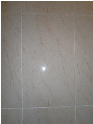
Figura 50: Alicatado Baño 1. 2015. Fuente propia.
