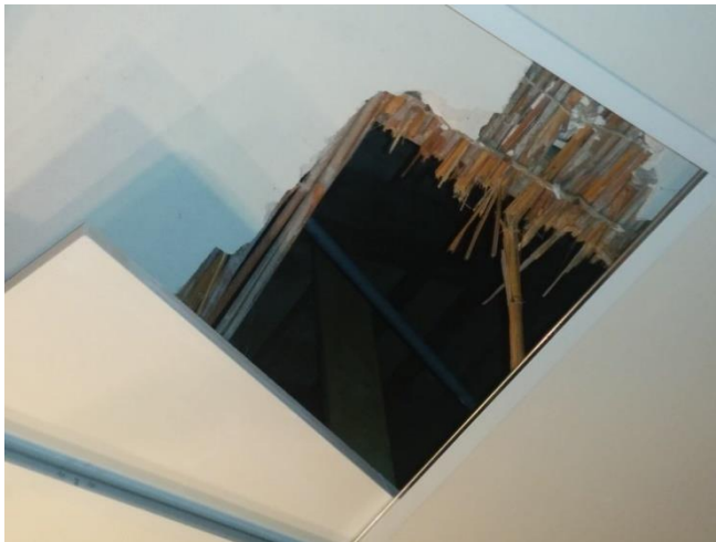
Figura 41: Falso techo de cañizo y enlucido de yeso. 2015. Fuente propia.
