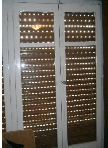
Figura 68: Ventana mirador. 2015. Fuente propia.
