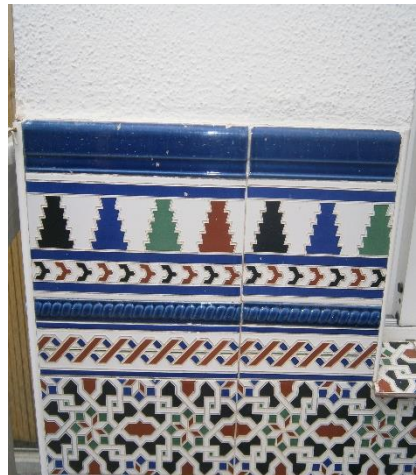
Figura 51: Azulejos hasta 1.5 m. 2015. Fuente propia.
