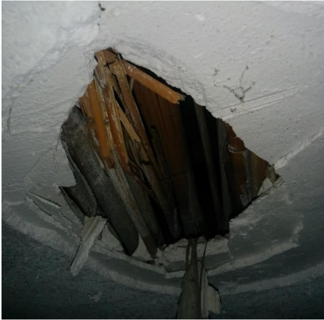
Figura 43: Falso techo de cañizo y enlucido de yeso. 2015. Fuente propia.
