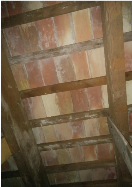
Figura 37: Viguetas y tableros cubiertos. 2015. Fuente propia.
