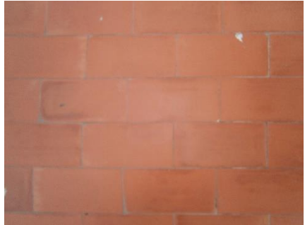
Figura 61: Pavimento acabado rasilla. 2015. Fuente propia.
