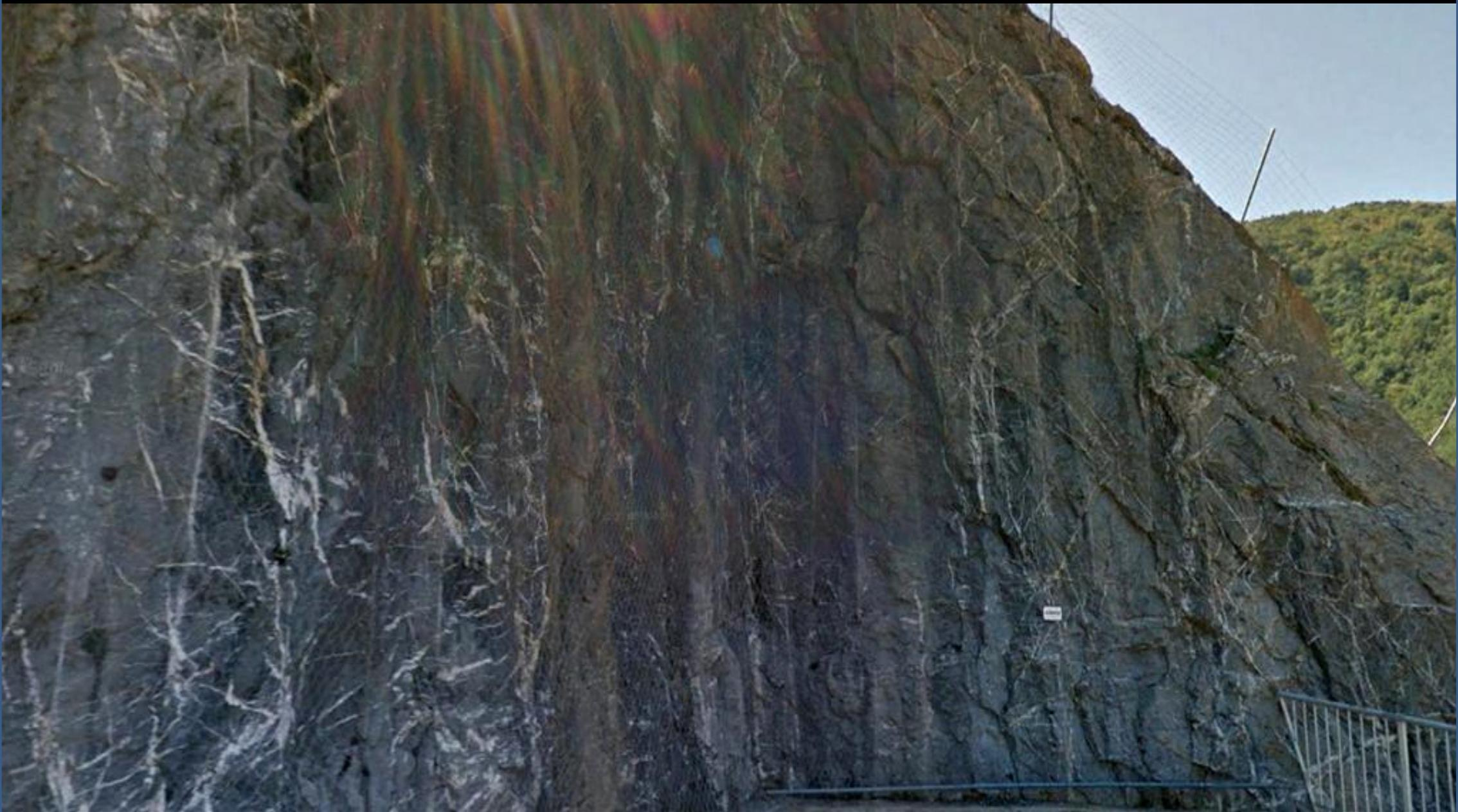
Detalle de las calizas tableadas negras- con grietas de tensión, rellenas de calcitas blancas- del Devónico Inf., y con mallazo, en el estribo izq. del Embalse de Lanuza. Centro E Hoja de Sallent, Huesca
