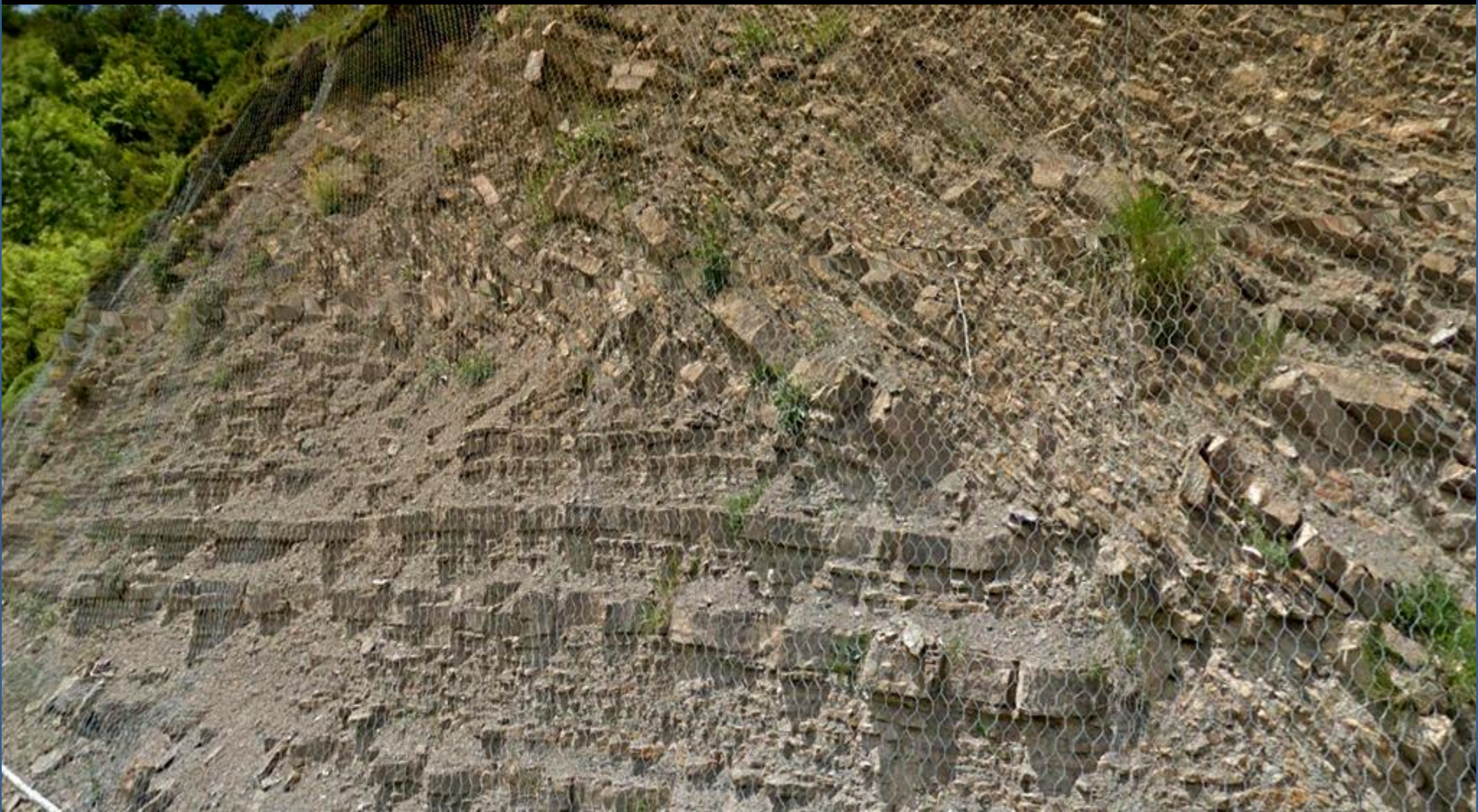
Al S de la anterior: Mallazo sobre pliegues falla en la serie flyschoides, de lutitas y areniscas del Luteciense, Eoceno Med. Terciario. Puerto de Cotefablo, Huesca. NE Hoja de Biescas.
