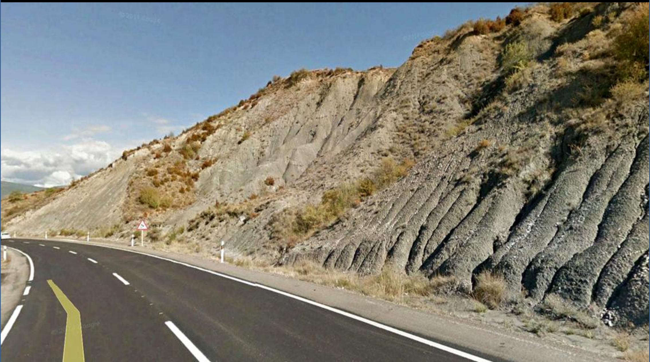
Metaestabilidad de ladera: Detalle imagen anterior. Cárcavas en las margas grises del Eoceno Sup. Terciario. E de Sabiánigo, Huesca. S Centro Hoja de Biescas.
