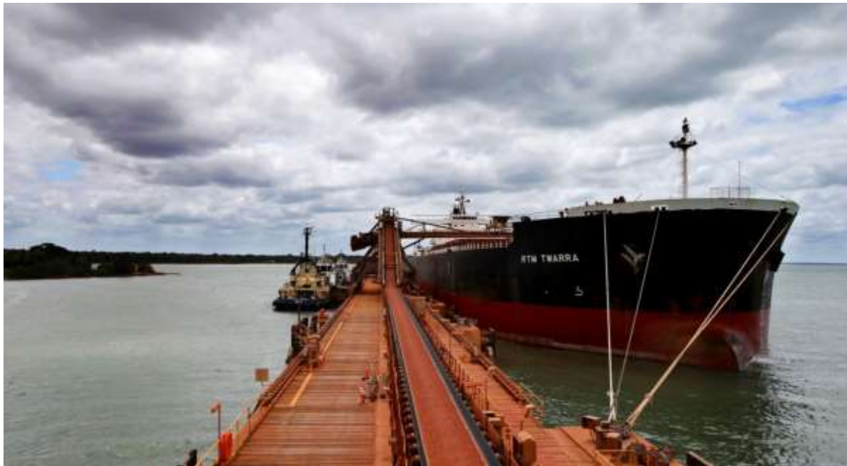
Ilustración 14: Muelle 1 del puerto de Weipa
