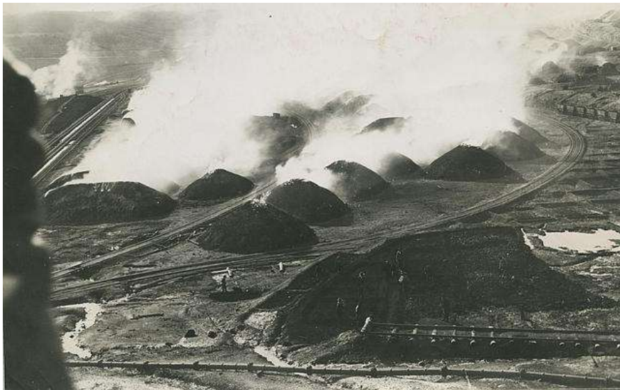
Ilustración 10: Calcinación de mineral al aire libre en las minas de Rio Tinto
