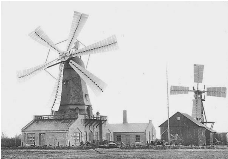
Figura 1. Equipo conversor de Poul La Cour.
