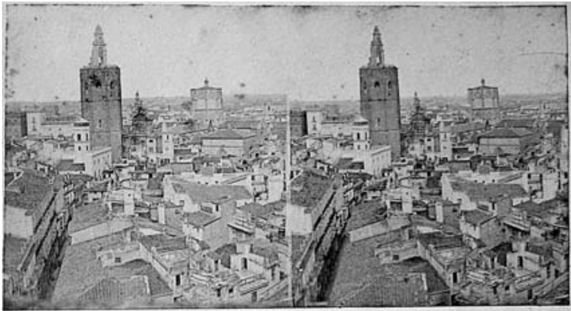
Fig. 1. Fotografía de hacia 1860, firmada por Radiguer et fils, donde se puede ver la fachada de la Casa de la Ciudad (a la izquierda del Miguelete) poco antes de ser derribada. Colección particular.
