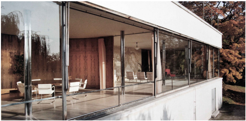
Fig. 26: Villa Tugendhat. Visión exterior del cerramiento de vidrio abierto al patio trasero. 2009.
