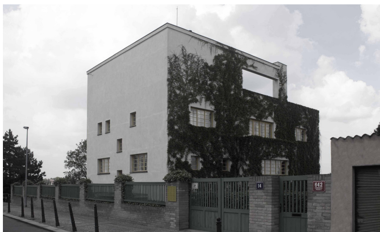
Fig. 15: Villa Müller. Vista de las fachadas este y sud de la obra restaurada. 2014.
