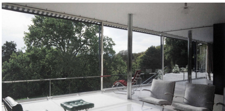
Fig. 30: Villa Tugendhat. Pilares cruciformes en el salón; participantes de la simetría horizontal y retranqueados de la fachada creando el voladizo. 1930s.
