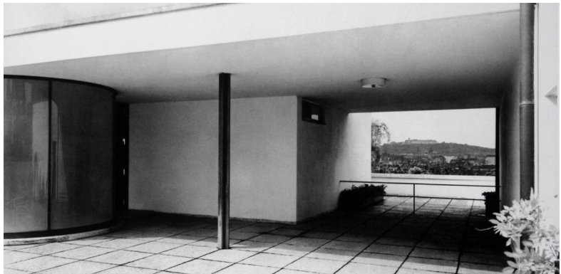
Fig. 18: Villa Tugendhat. Espacio creado en la planta de acceso entre el cuerpo de habitaciones y recepción y el garaje. 1930s.
