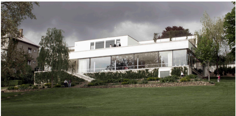
Fig. 32: Villa Tugendhat. Vista frontal de la fachada sur-oeste de la obra restaurada. 2014.
