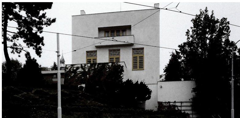
Fig. 3: Villa Müller. Vista de la fachada norte. Los muros blancos esconden la domesticidad de la casa al exterior. 1930s.
