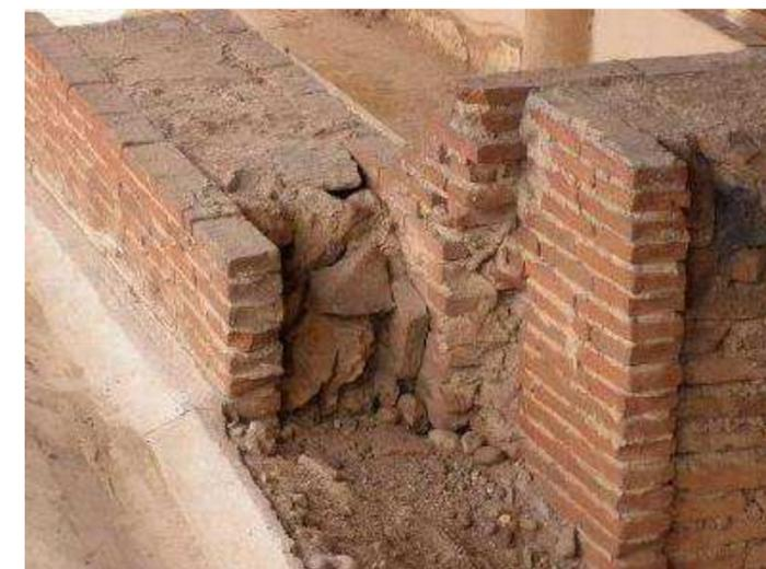
FIG. 42 . Ejemplo de muro de carga ([www.arqhys.com](http://www.arqhys.com))
