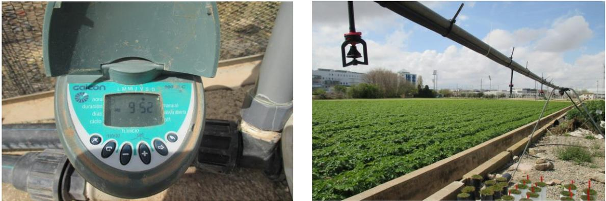
Figura 5: sistema de riego utilizado, derecha (tubería y aspersores de polietileno), izquierda (programador de riego Galcon 9001C).
