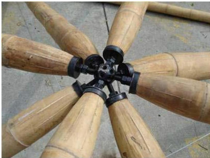
Figura 9: Unión cónica con esfera, J. Stamm.
