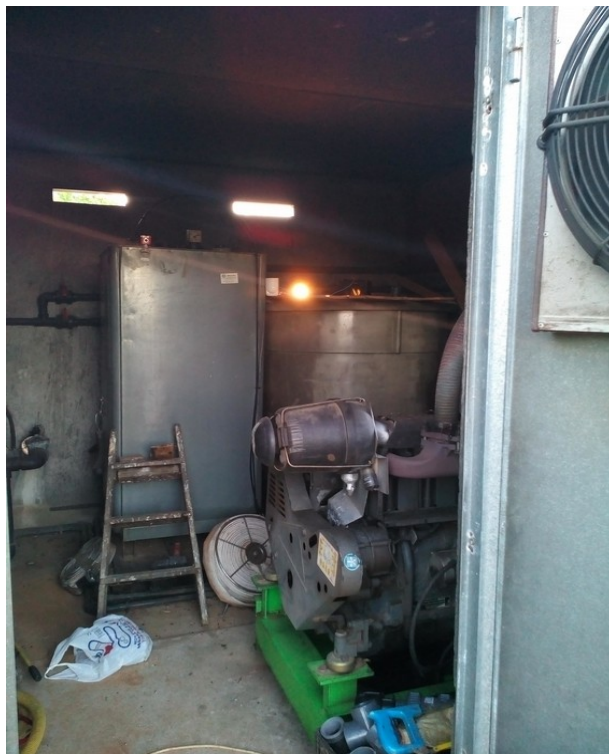
Ilustración 58: Pruebas de campo montaje prueba funcionamiento 1
