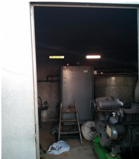
Ilustración 59: Pruebas de campo montaje prueba funcionamiento 2
