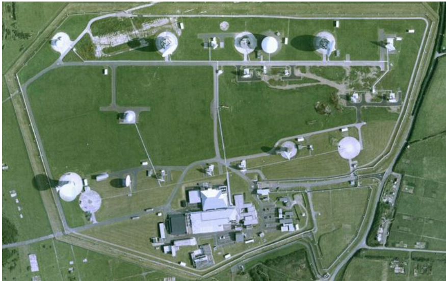
Figura 2: GCHQ Bude. Composite Signals Organisation (CSO) Station en Morwenstow (Cornwall, Inglaterra), operada por el GCHQ. Fuente: Imagen tomada de la web de Duncan Campbell dedicada a sus investigaciones sobre la red ECHELON. http://www.duncancampbell.org/content/echelon (Último acceso: 28/08/2015)
