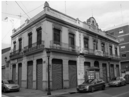
Figura 1. Estado actual edificio del Casinet. Cabanyal. Valencia
