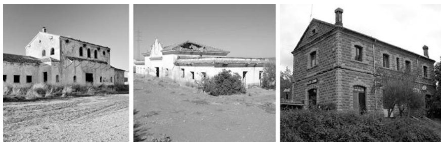
Figura 1. Estaciones de Villapalacios (Albacete), Arroyo Ojado (Jaén) y Cellers (Lérida).
