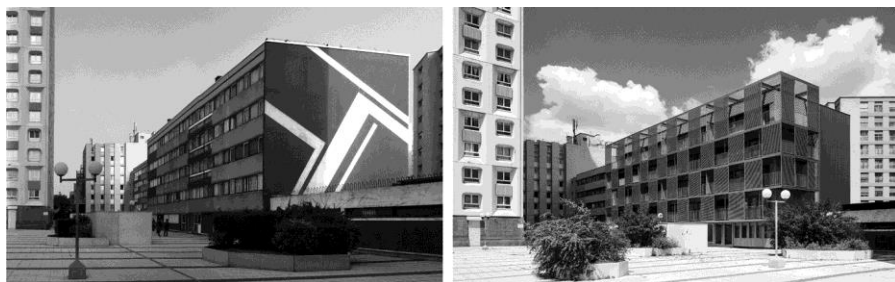
Figura 2. Prima e dopo l'intervento: Square Vitruve, Parigi – XX arrondissement - Atelier du Pont (photo credits: Atelier du Pont)
