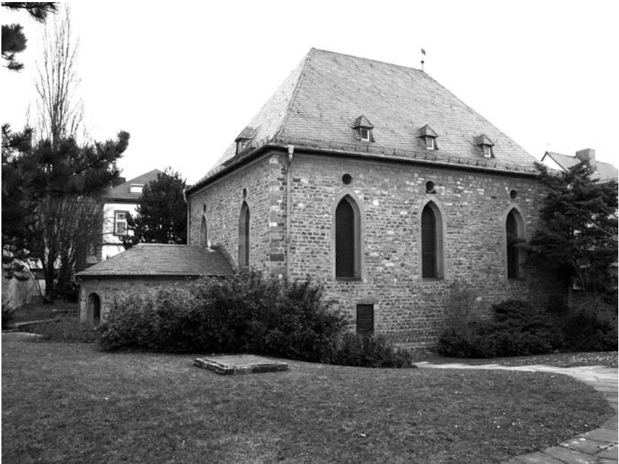
Figura 2. Conservación de muros en buen estado en Sinagoga de Worms y reconstrucción de la parte superior con técnicas tradicionales. Fuente imagen: Ilsemarie (2005) en www.wikimedia.org
