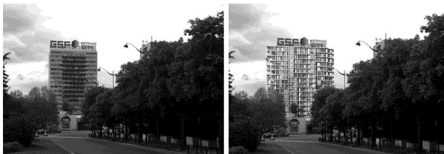
Figura 1. Trasformazione della torre Bois le Prêtre, Parigi – XVII arrondissement - Lacaton&Vassal + Druot (photo credits: Lacaton&Vassal Atelier)
