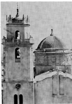
Figura 4. Reparación de la teja de la cúpula durante las intervenciones entre 1972 y 1976. Fuente: Archivo de la Parroquia Ntra. Sra. de Belén de Crevillente.
