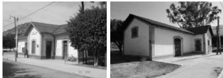
Imagen 5. Vista de la fachada principal de la estación de Buena Vista, en dos etapas posteriores a su intervención. 2006 y 2007. Archivo del autor.
