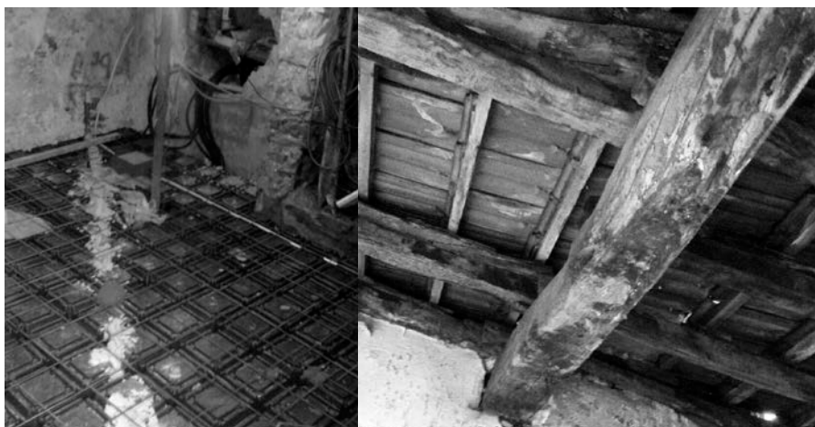
Figura 6. Interventi interni: realizzazione dell'aerazione del solaio controterra, individuazione orditura primaria non marcescente da recuperare 12
