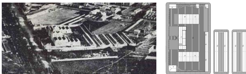
Figura 1. Foto vista aérea de Albacete 1930. Conjunto industrial Fontecha y Cano.
