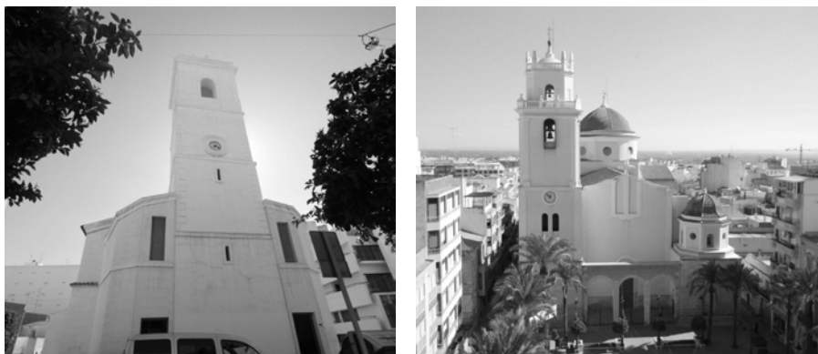
Figura 1. Imagen izquierda. Torre de la antigua Parroquia (ubicada en el solar primigenio, ahora Mercado de Abastos). Fuente: propia. Imagen derecha. Vista de la fachada principal de la iglesia en su ubicación actual (Plaza de la Constitución). Fuente: propia.
