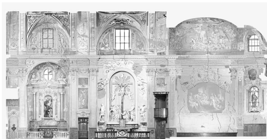
Figura 1. Chiesa di S. Eusebio, Castel San Pietro (Svizzera). Quadro fessurativo prospetto settentrionale
