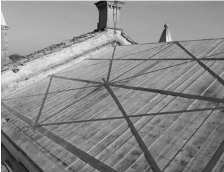
Figura 2. Intervento di consolidamento strutturale realizzati sulla copertura del Duomo di Colorno
