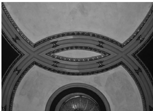
Figuras 8 y 9. Decoraciones circulares en el techo.
