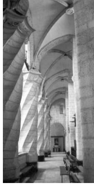
Figura 2. Pilares entorchados. Iglesia de Santiago de Villena.
