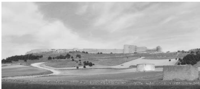
Figura 3. Imagen del lienzo sur de la muralla, del valle y de dos palomares.
