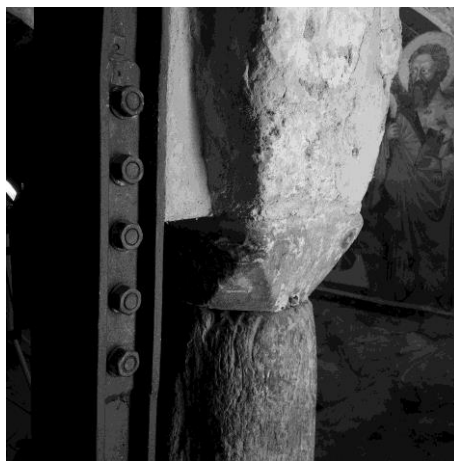
Figura 25 – Dettaglio dell'affiancamento della nuova struttura metallica alla colonnina
