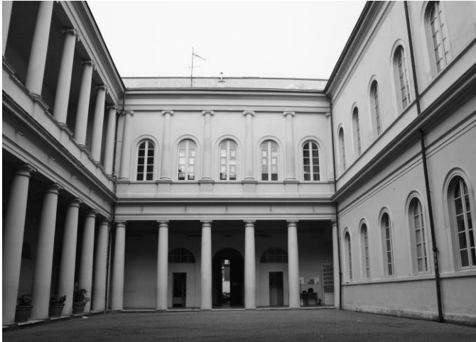
Figura 1. Foto della corte interna verso l'ingresso
