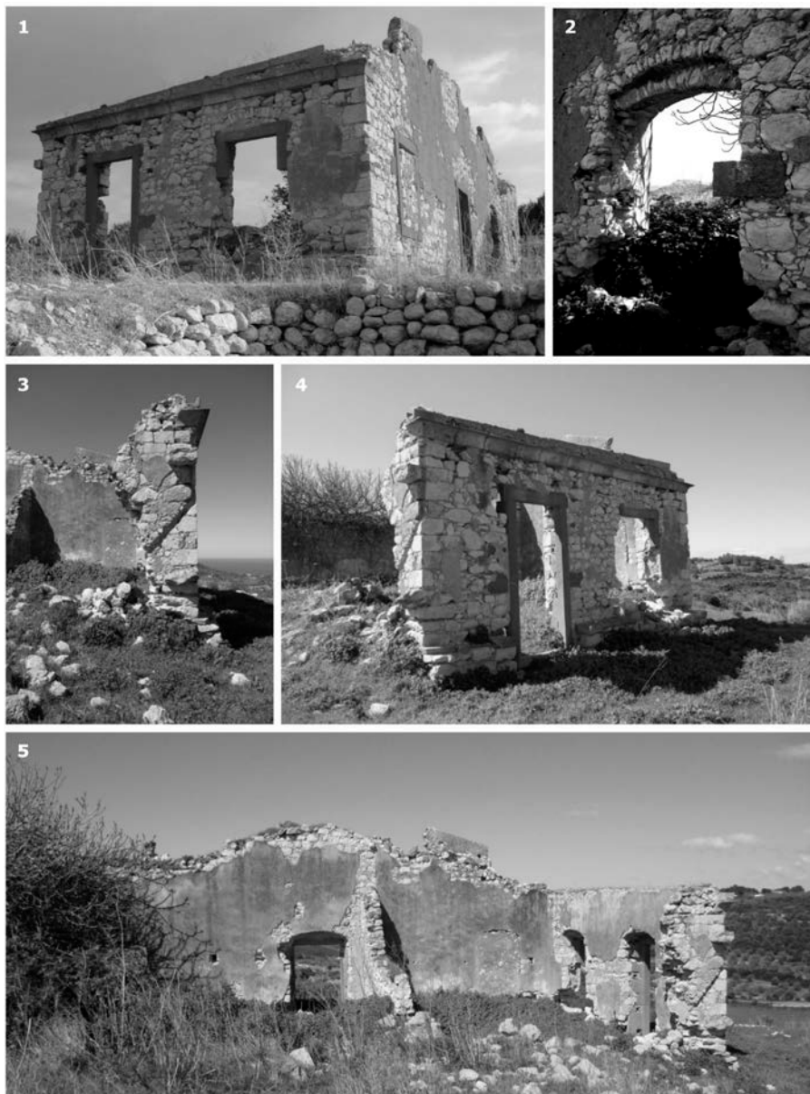
Figura 6. Documentazione fotografica: 1- vista dei prospetti nord e ovest, 2- dettaglio dell'arco a doppia ghiera, 3- dettaglio del sistema di smaltimento delle acque meteoriche, 4- prospetto nord, 5- vista dello spazio interno dell'abitazione principale
