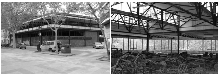
Fig 9 y 10. Exterior e interior Edificio Frutagut.
