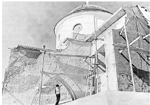
Figura 4. Reparación de la teja de la cúpula durante las intervenciones entre 1972 y 1976. Fuente: Archivo de la Parroquia Ntra. Sra. de Belén de Crevillente.
