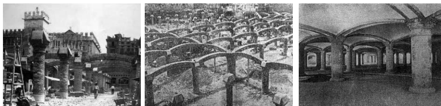
Figs. 3,4 y 5. Construcción de pilares y arranque de arcos y bóvedas en Pi. Sótano
