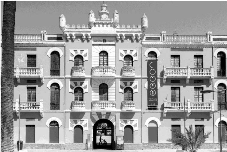
Figura 4. Pabellón 1 del Cuartel de Artillería de Murcia. Fotografía: Jose Luis Carrillo. Archivo Puertas de Castilla
