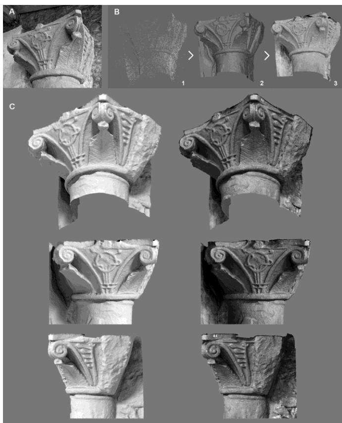
Figura 4. A. Foto del capitello della cappella. B. Fasi di generazione del modello tramite SfM: 1. Nuvola di punti; 2. Mesh; 3. Mesh con texture. C. Render del modello dettagliato del capitello, senza e con mappatura.
