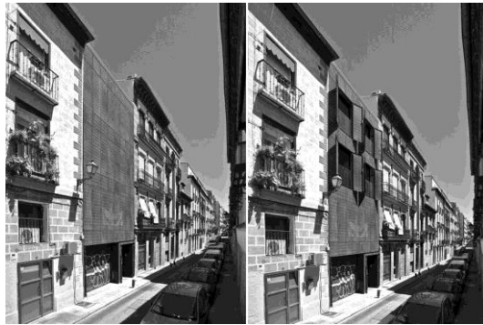
Figura 1. Madrid, le due versioni del prospetto.
