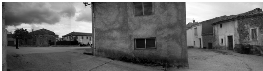
Figura 2. Vista de la Plaza del Castillo a la izq. La herrería en el centro y la ampliación de la Casa del Parque a la derecha.
