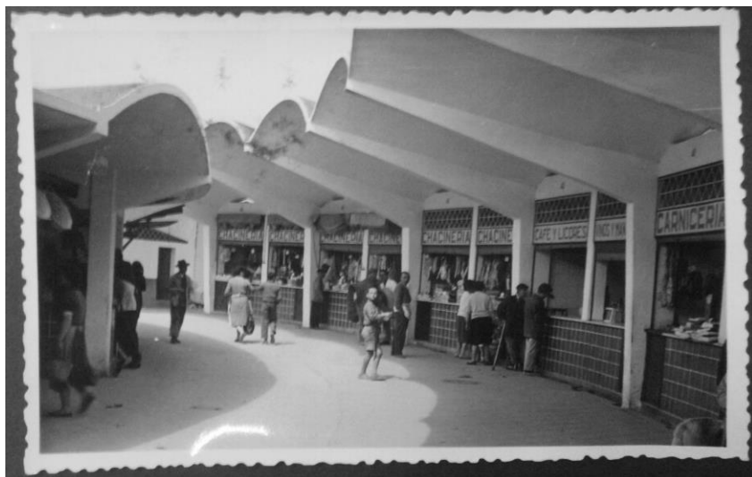
Figura 3. Mercado de abastos de Andújar. Interior. Detalle de voladizo 5 .
