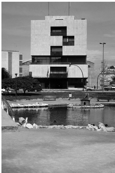
Figura 3. Facciata principale dell'edificio
