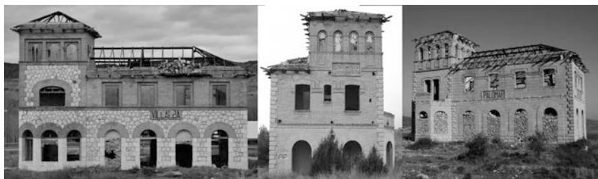
Figura 2. Estaciones de Villaba, Peralejos y Palomar de Arroyos, actualmente abandonadas.
