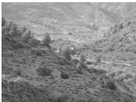
Figura 4. Panorámica del puente rambla de Alcotas
