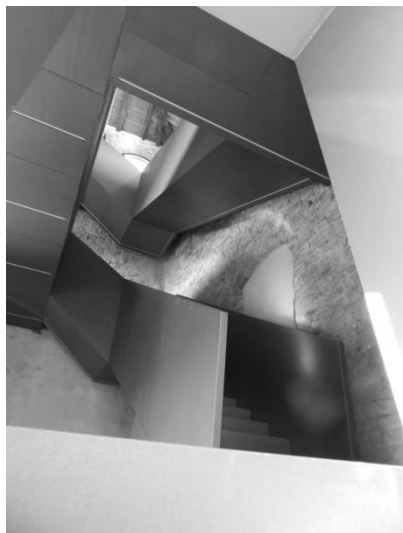
Figura 4 – Sviluppo della nuova scala metallica
