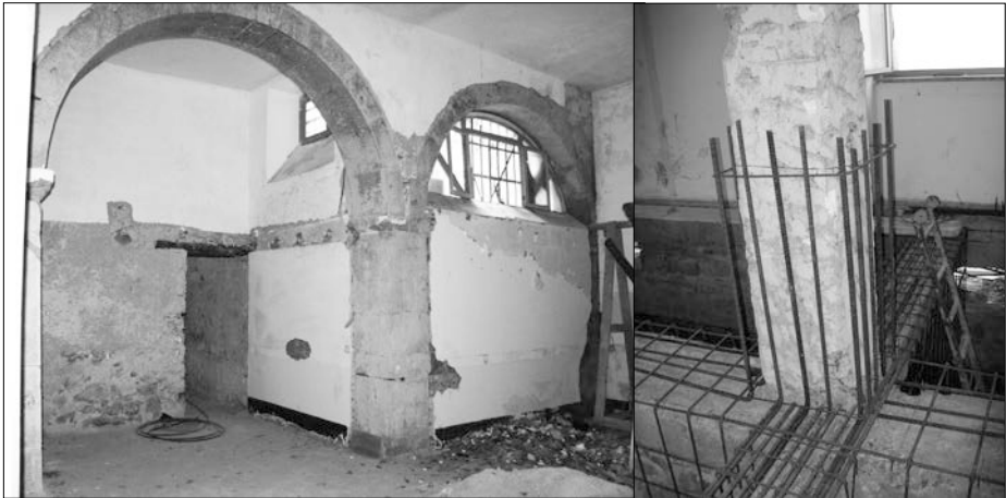
Figure 3, 4. Permanenze del chiostro dell'antico monastero. A destra: interventi di consolidamento con cemento armato delle strutture in muratura esistenti.
