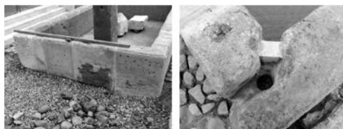
Figura 4. Detalle del alzado oeste del pretil tras la aplicación de prótesis de caliza y reintegración mediante mortero de restauración. Intervención en el rebosadero original de esquina para dejarlo visto.
