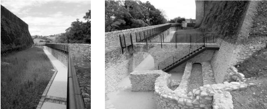
Figure 5,6. Camminamenti del lato occidentale del primo giro di mura visti da nord e da sud
