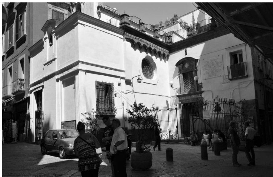
Figura 5. Napoli, Chiese di San Gennaro all'Olmo e San Biagio dei Librai. I prospetti dopo l'intervento di restauro. Foto M. Villani (2011)
