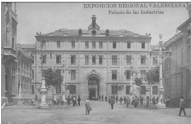
Figura 1. Fachada del edificio de Tabacalera, entonces Palacio de La Industrias, 1909.
