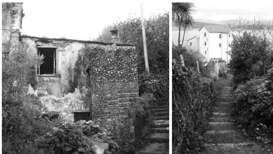
Figura 4,5. Prospetto del fabbricato oggetto di restauro. A destra: la scalinata storica.
