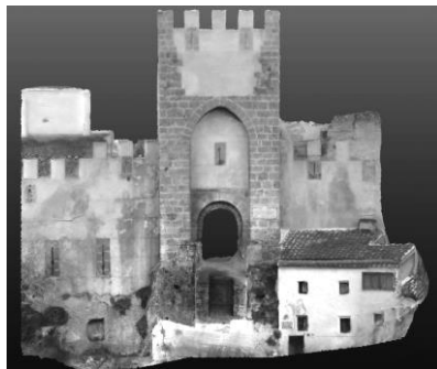
Figura 8. Ortofotografía del acceso a través del puente, mostrando la calle en el nivel inferior.
