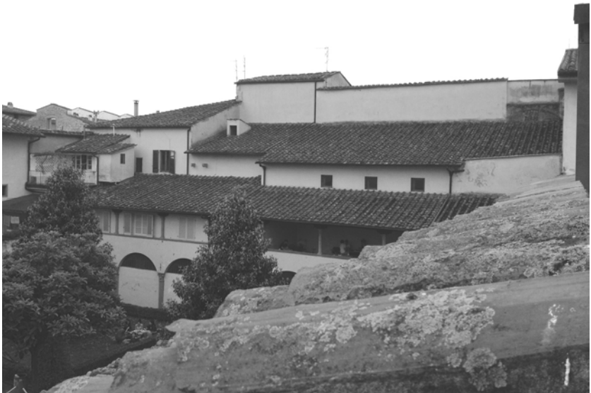
Figura 3. Vista corpo meridionale del complesso didattico di santa Verdiana.
