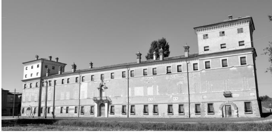
Figura 2: il fronte principale del palazzo allo stato attuale.
