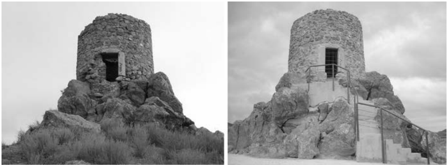
Figura 1. Torre del Molinete antes (izquierda) y después (derecha) de la intervención.
