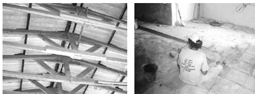
Imagen 6. Reposición de elementos de madera en soporte de cubierta y cambio contextual de piso.2005 y 2006. Archivo del autor
