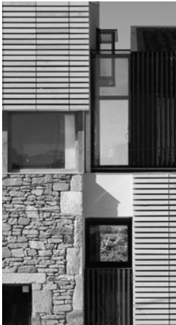
Figura 4. Vista de los encuentros en fachada entre muros existentes y su reinterpretación contemporánea
