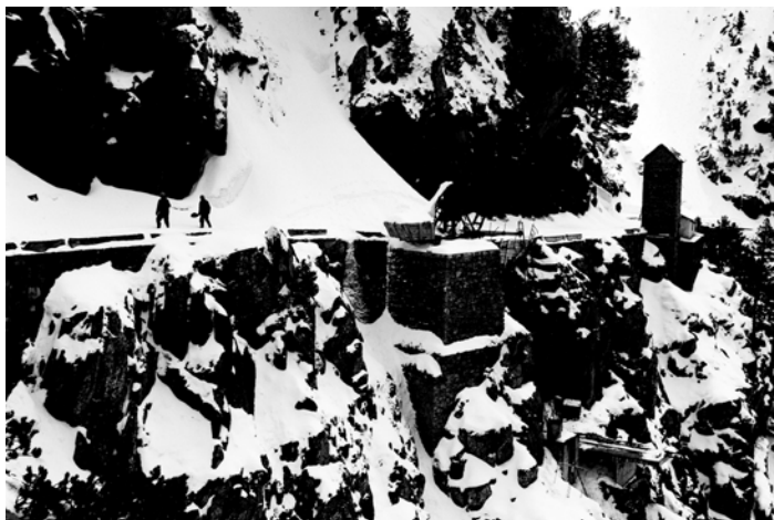
Figura 3: Excavación de Ibón de Yserias, de la central hidráulica de Ip en Canfranc (Mermando Antonio Valenzuela, 1970). Fuente: Fondo Histórico ENDESA.
