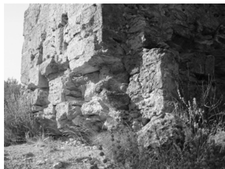
Figura 5. Detalle del puente rambla de Alcotas
