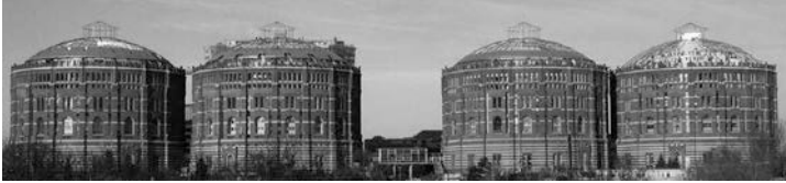
Figura 1. Gasómetros de Viena. (Pöschek, A. 2002).
