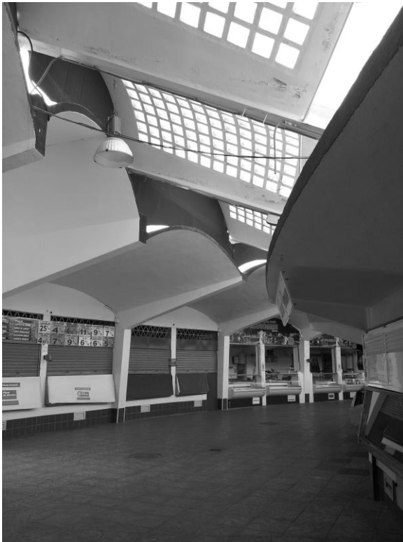
Figura 4. Mercado de abastos de Andújar. Interior. Estado actual 9 .
