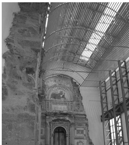
In alto, alcune fasi del restauro delle superfici a stucco e degli affreschi parietali: preconsolidamento con bendaggio e rimozione dei depositi superficiali; al centro e in basso, si osserva lo stato dei luoghi a cantiere ultimato e l'allestimento del Museo della Memoria.
