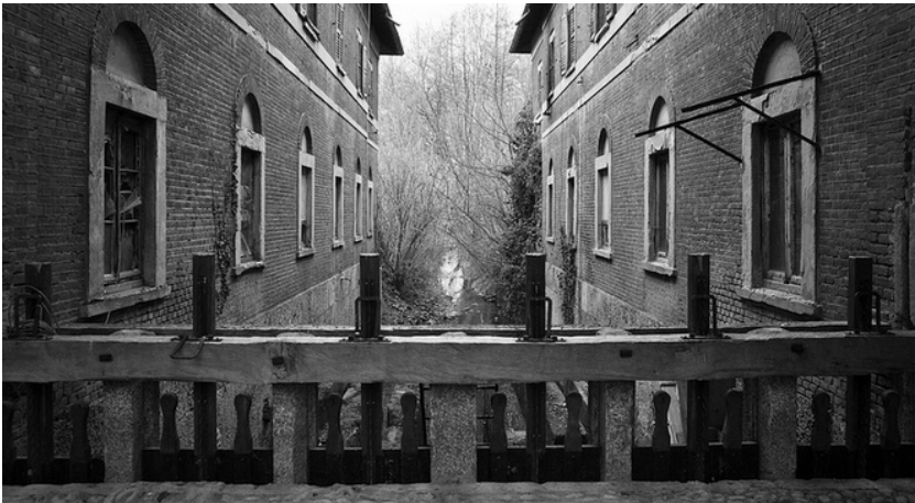
Figura 1. Vista desde el porche mirando hacia la acequia del Lambretto en correspondencia de las palas hidráulicas y de las puertas que permiten regular el flujo de agua, 2015.
