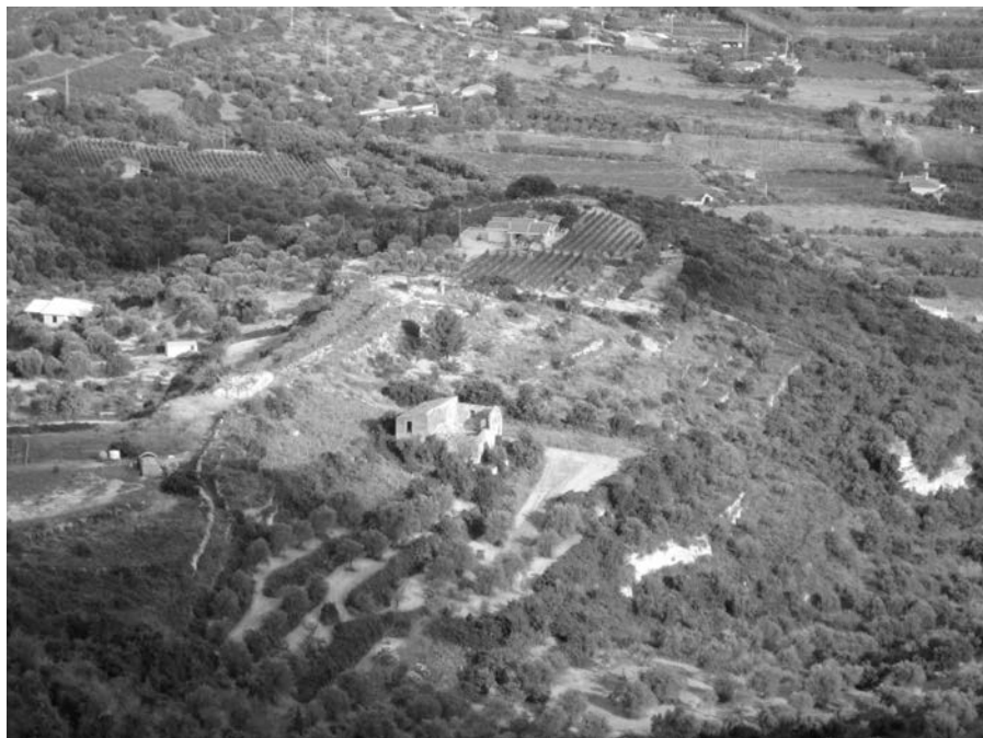
Figura 1. Edificio rurale in stato di rudere in località Sorighes nel territorio di Bosa e Magomadas.
