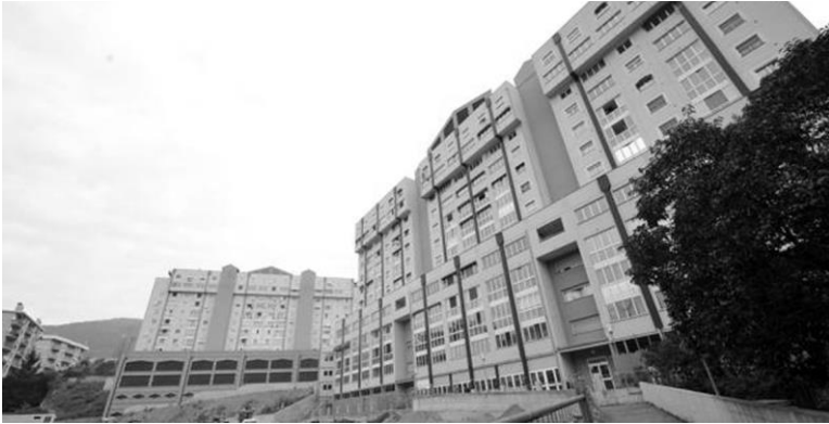
Figura 2. Genova. "L'edificio pilota" durante i lavori.
