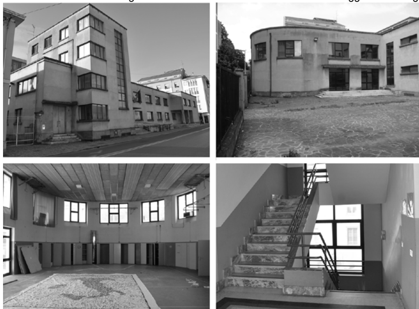
Figura 1. (alto sinistra) Prospetto principale su via Solferino con in primo piano la torre nord. In evidenza i serramenti sostituiti a fine anni '80. (alto destra) Il fronte della palestra e il cortile antistante, oggi di dimensioni molto ridotte. (basso sinistra) Vista interna della palestra. (basso destra) Il corpo delle scale nord. In primo piano il pavimento a mosaico e le finiture della scala in marmo bianco e bardiglio nuvolato.
