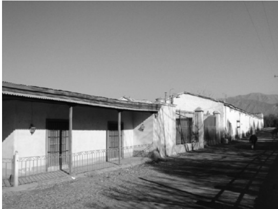
Figura 1: Bodega Panquehua – Paisaje protoindustrial (foto autora)
