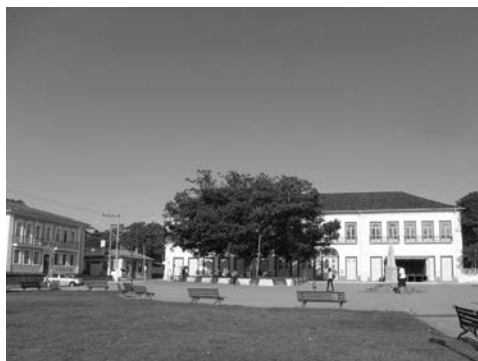
Figura 1. Imagen del edificio, en la Plaza Rubião Júnior (Fotografía Lara Melo Souza, 2011).
