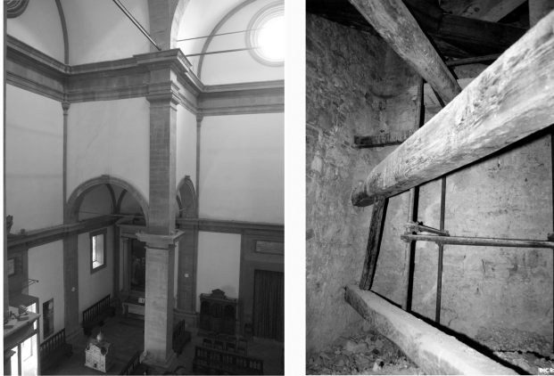
Figura 6. Cortona, chiesa di S. Maria Nuova; cappella Cecchetti: vista interna e del sottotetto con le catene lignee diagonali sovrapposte e, più in alto, le catene lignee parallele alle pareti perimetrali.
