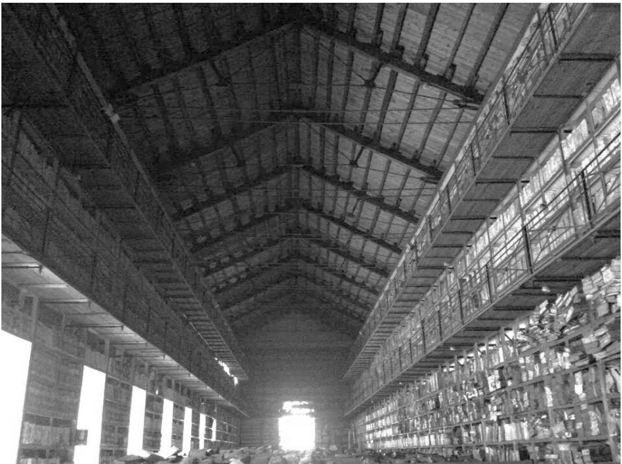
Figura 5. La cosiddetta "sala delle capriate", uno degli spazi d'interesse storico ed architettonico della Gancia
