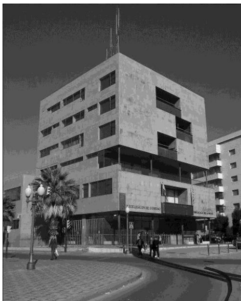
Figura 6. Vista esterna dell'edificio
