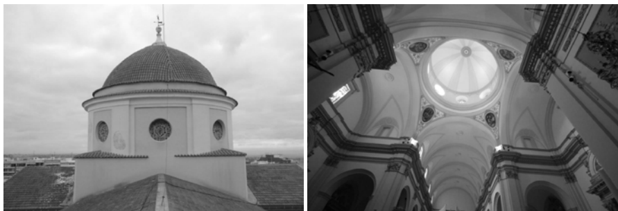
Figura 3. Imagen izquierda: Vista exterior de la cúpula desde la nave central. Fuente: propia. Imagen derecha: Vista interior de la nave central desde la cabecera. Fuente: propia.
