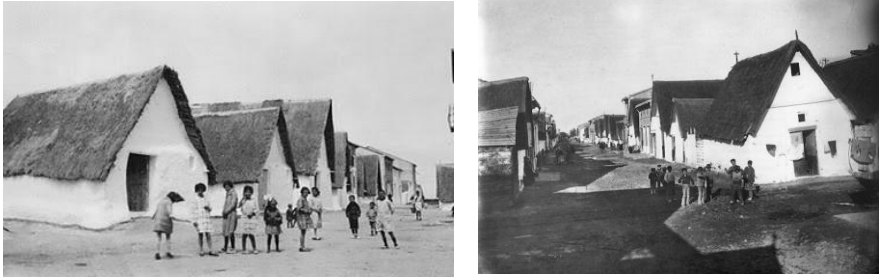
Figura 1 y 2. Barracas hechas con cubierta de cañas y encaladas
