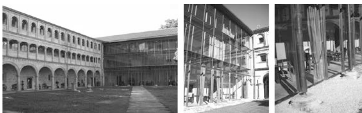
Figura 1. Santo Estevo de Ribas de Sil (Ourense): vista y detalles del muro cortina. La intervención ha respetado la autenticidad del monumento mediante una actuación reversible.
