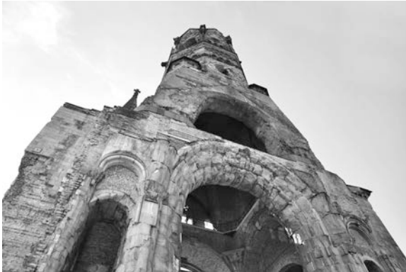
Figura 4. Iglesia Conmemorativa " Kaiser-Wilhelm ": El valor documental de la materia en su estructura destruida irreversiblemente con la transformación del sistema mecánico isostático a uno hiperestático mediante cosidos armados. Fuente imagen: www.disfrutaberlin.com
