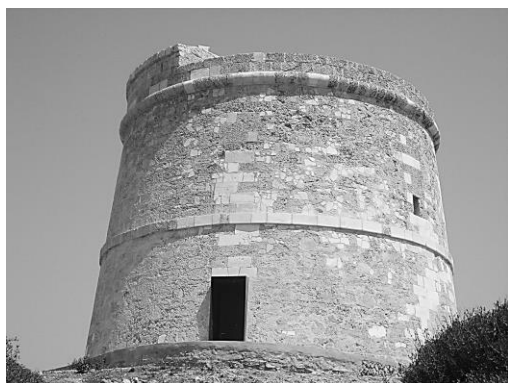
Figura 4. Vista general de la Torre de Son Ganxo.
