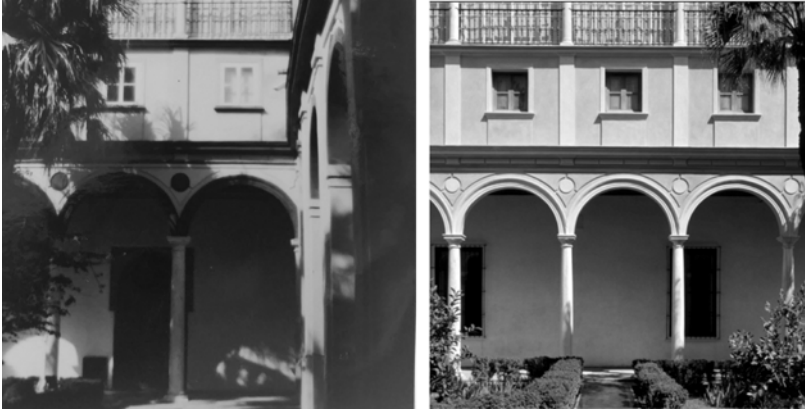
Figuras 1 y 2. Fachada manierista del Patio del Príncipe del Real Alcázar de Sevilla, antes y después de su restauración en 2001. Su acabado era con polímeros y se restauró con morteros de estuco, compuestos de cal, marmolina y pigmentos minerales (Robador M.D. 2003).
