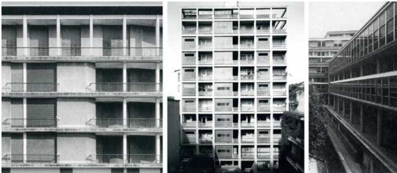
Figura 3. Le relazioni struttura/chiusura in tre casi: (da sinistra) Casa Tognella o "casa al parco" a Milano (I. Gardella, 1947); Edificio per abitazioni ed uffici in via Broletto a Milano (L. Figini e G. Pollini, 1947-8); Facoltà di Ingegneria a Napoli (L. Cosenza, 1955-70) .
