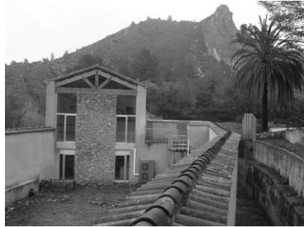
Figura 3. Estado actual tras la rehabilitación.
