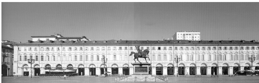
Figura 2. Un lato della piazza dopo il restauro
