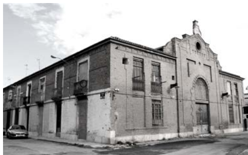
Figura 7. Edificio de la Lonja de la Marina Auxiliante (Pastor 2010)
