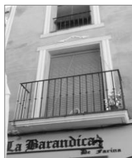
Figura 6. Cehegín. Detalle de barandilla de balcón y moldura de vivienda.
