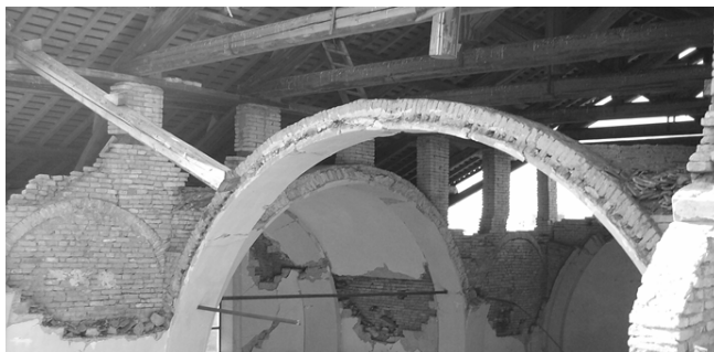
Figura 5. Vista della parte soprastante la trabeazione della navata destra; si noti il sistema di appoggio delle capriate e gli archi soprastanti la trabeazione (Foto Ing. Pongiluppi)
