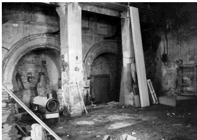
Figura 2. Vista de los arcosolios en el interior del taller del periódico “Las Provincias”
