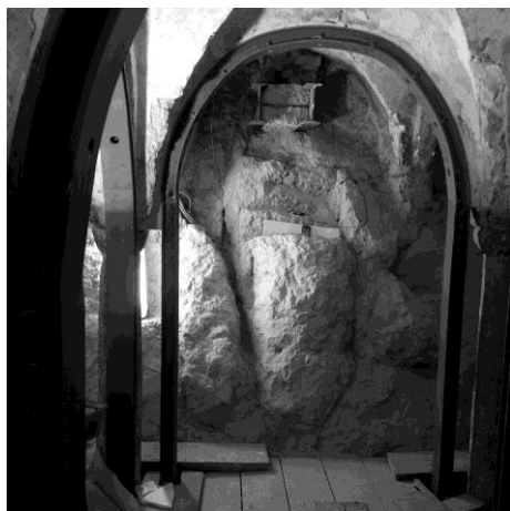
Figura 4 – Gazebo strutturale messo in opera e moncone del presidio strutturale del 1930
