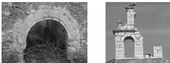
Figura 5 y 6. Arco que cubre la entrada principal, situada en la fachada Sur y Espadaña
