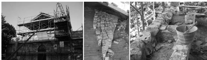
Figura 3. Fasi di intervento: smontaggio, catalogazione e ricostruzione con diatoni
