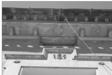
Figura 9. Cehegín. Detalle de alero con molduras decoradas.
