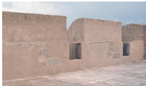
Fig. 10- Foto de parapeto del Baluarte Real con restos del parapeto original localizados bajo los revestimientos modernos (M a Josefa Balaguer, 2013)
