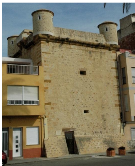
Fig. 4- Vista exterior de la torre de Torrenostra.
