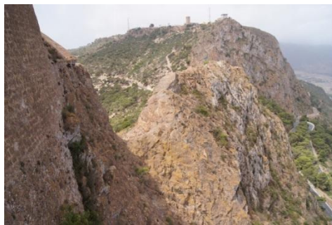
Fig. 8- Vista de la cortadura desde el revellín (Souad Metair, 2013)
