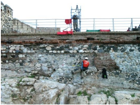
Fig. 7- Operario con arnés y equipo de escalada reparando la fábrica en la muralla del castillo de Salobreña.
