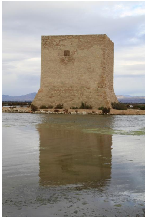
Fig. 7- Torre de Tamarit (Santiago Varela, 2014)
