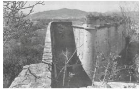
Fig. 5- Flanco y cara de uno de los baluartes
