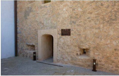
Fig. 11.- Acceso a la Torre de Los Caballos después de la restauración. (P.E. Collado)
