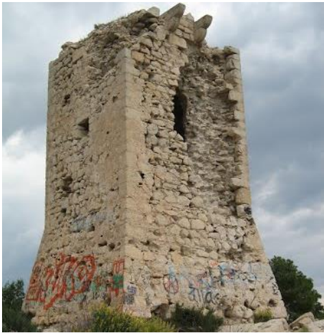
Fig. 4- Torre de L'Aguiló (Villajoyosa). Detalle previo a la intervención: muros a sacco, con mampuestos y con sillería en las esquinas (J. Ramos).
