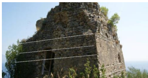
Fig. 6- Massa Lubrense (Nápoles). Torre de Recommone. Detalle (líneas blanca) de las fajas de jornales que se pueden apreciar en los alzados (V. Russo).
