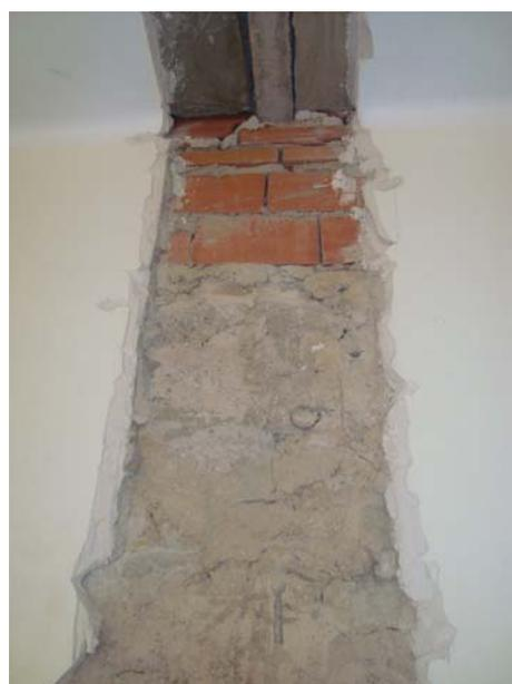
Fotografía nº 5: Apoyo de viguetas sobre muro de mampostería.
