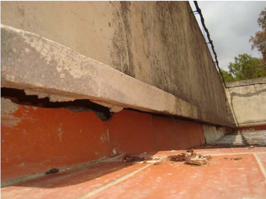
Fotografía nº 16: Ventilación cubierta plana a la catalana.
