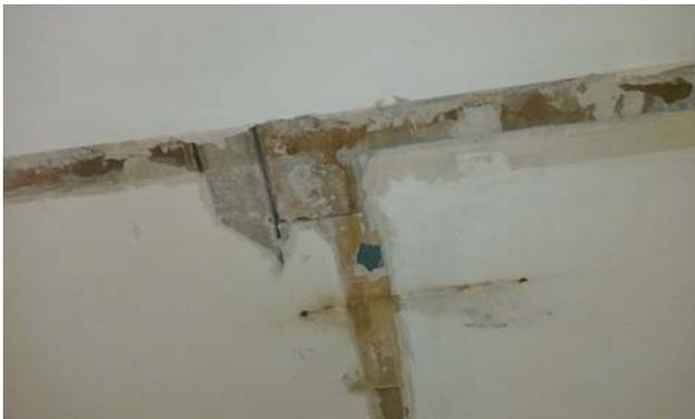
Fotografía nº 8: Forjado de viguetas de hormigón y bovedillas de yeso.
