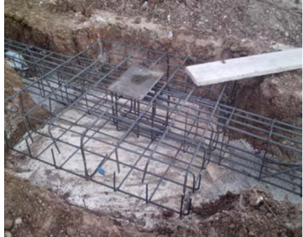
Imagen 18. Armadura de acero. Fuente: Fotografía tomada por el autor
