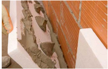
Imagen 13. aislamiento con placas de EPS.
