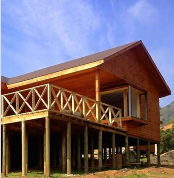
Imagen 20. Vivienda realizada con pilotes de madera. Fuente: www.habitissimo.cl .
