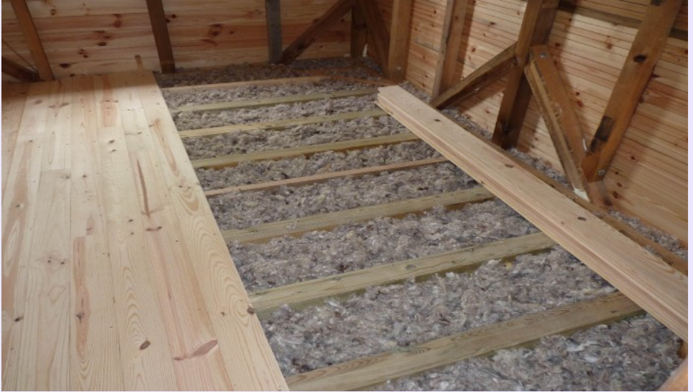
Imagen 28. Aislamiento en suelo con lana de oveja. Fuente: www.homoefficiens.es
