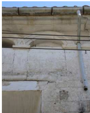
Figura 42. Detalle de elementos de evacuación de aguas. Elaboración propia
