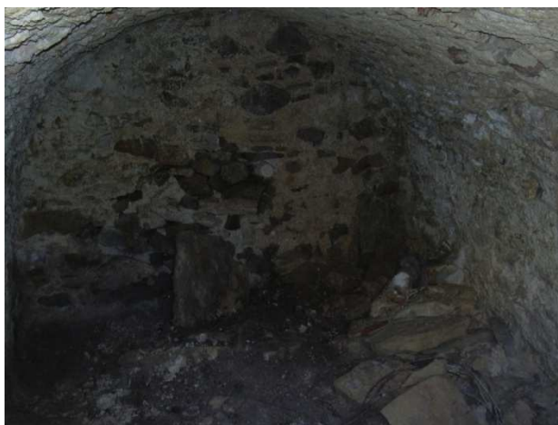
Figura 35. Bóveda de cañón de mampostería ordinaria. Elaboración propia
