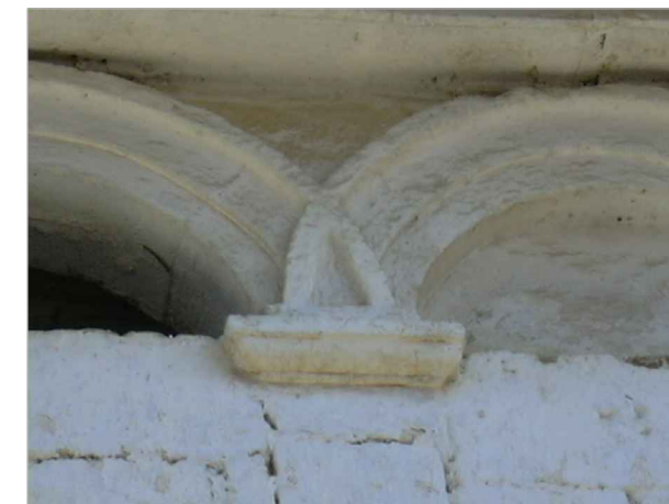
5. Huecos de fachada con dintel curvo con molturas cegados alternamente.
