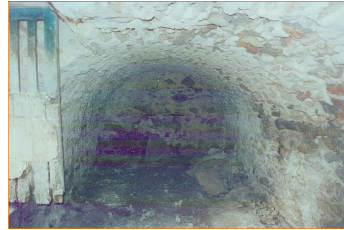
5. Aljibe formado por una bóveda de cañon contruida con mampostería ordinaria. Utilizado como almacén en su época de construcción.
