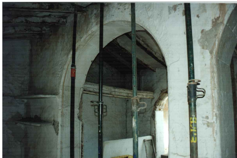
2. Planta segunda apuntalada. Arcos de medio punto en estructura vertical.
