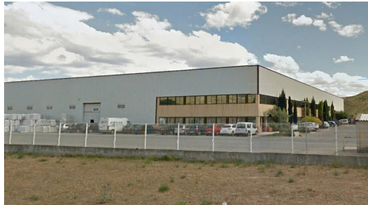
Fig. 21. Subunidad industrial (Fuente: Google Street View)
