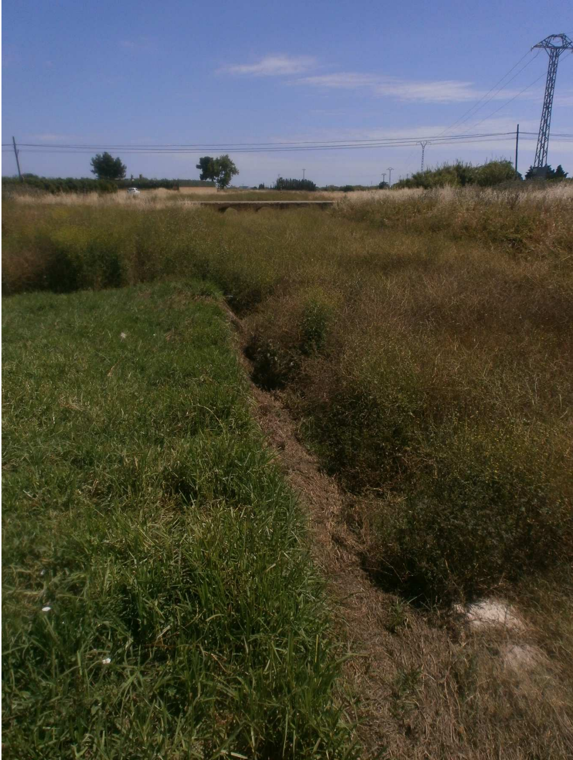
Foto 3: Barranco aguas arriba de la obra de fábrica
