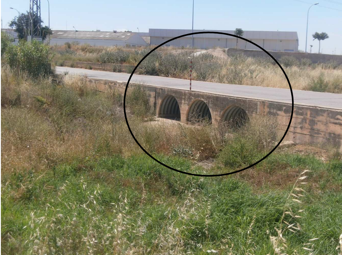
Foto 4: Obra de fábrica a sustituir por el puente proyectado.
