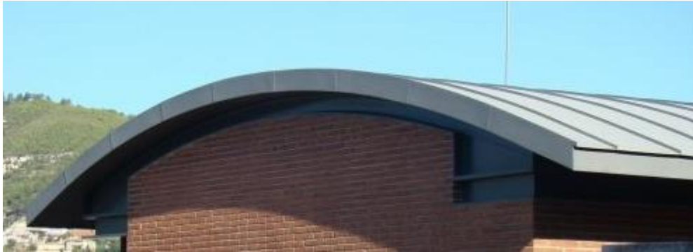
Figura 11 : Ejemplo de cubierta con panel sándwich curvo
