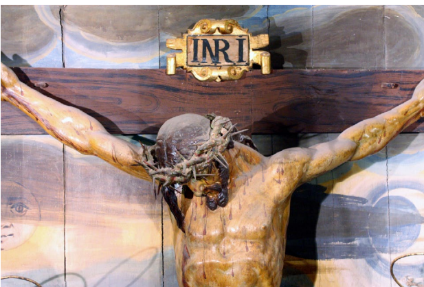
Figura 23. Detalle de las fendas abiertas entre los diferentes paños que conforman la escena de “La Crucifixión”.
