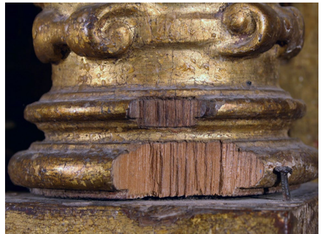
Figura 25. Pérdida de madera en la base de una de las columnas del primer cuerpo.
