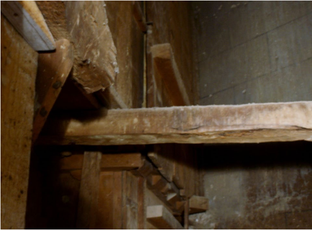
Figuras 6. Detalle del tirante de unión entre el retablo y el muro situado entre el banco y el primer cuerpo.
