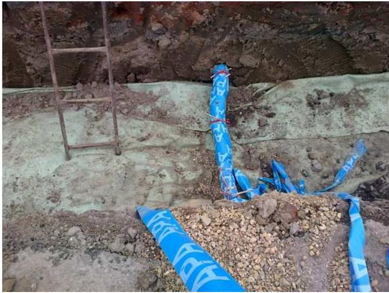
El control de la pendiente se realizaba mediante ayuda de nivel laser y comprobaciones periódicas por parte del topógrafo de la obra.
