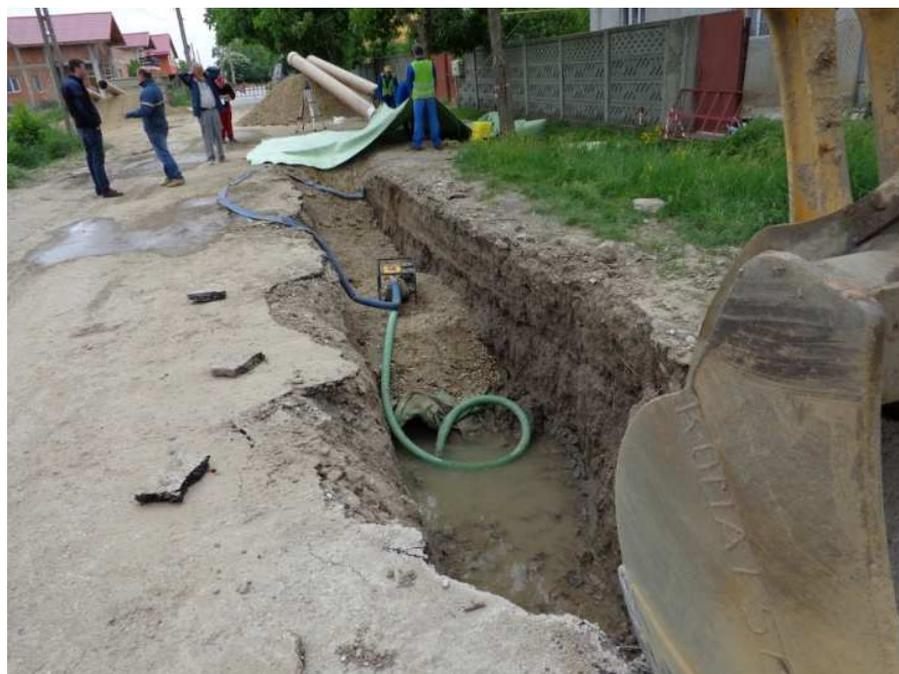
En algunas ocasiones bombear con bombas no era suficiente y había que bajar el nivel freático con sistemas de succión en el terreno mediante filtros.
