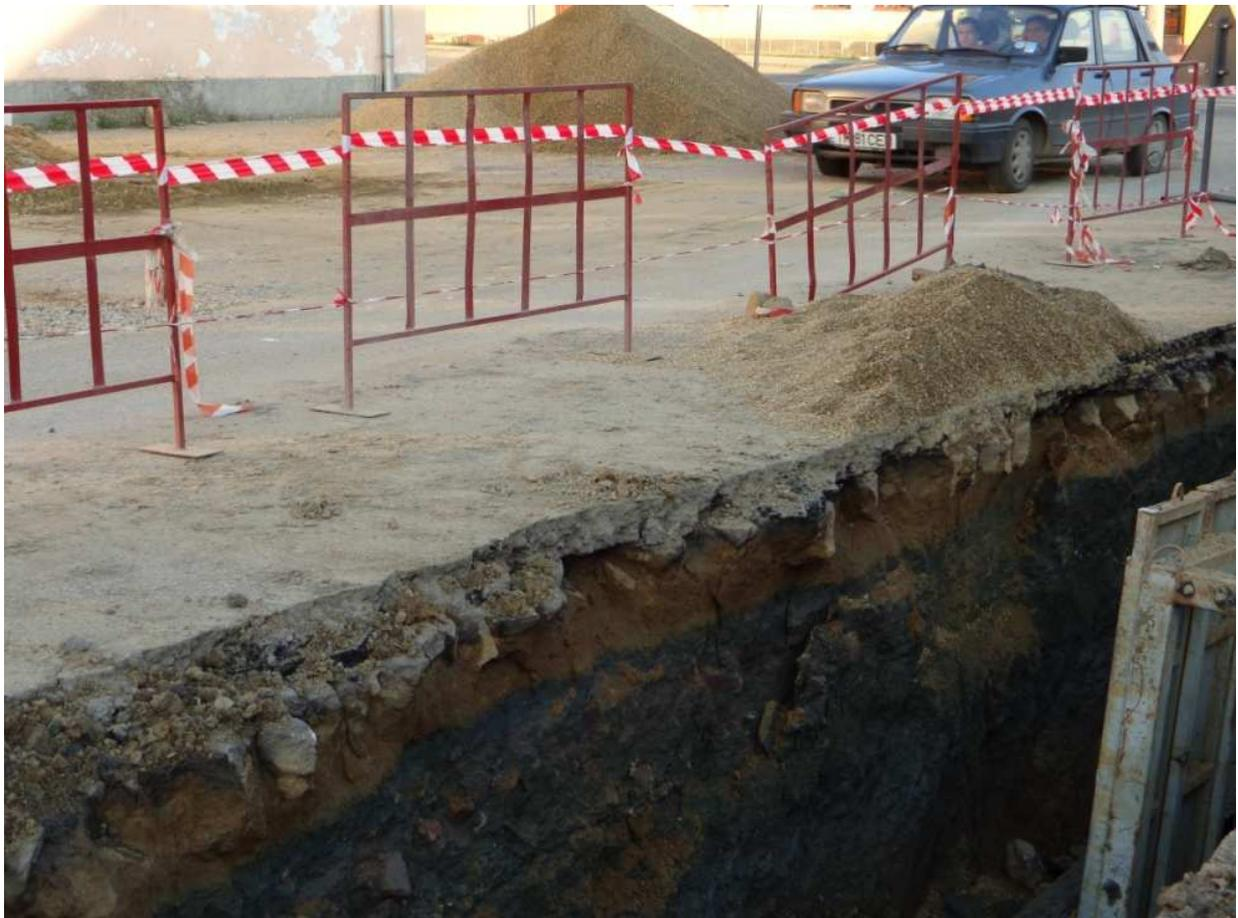
Las entibaciones utilizadas eran del tipo metálico, se utilizaban incluso para la colocación de los pozos prefabricados de hormigón.
