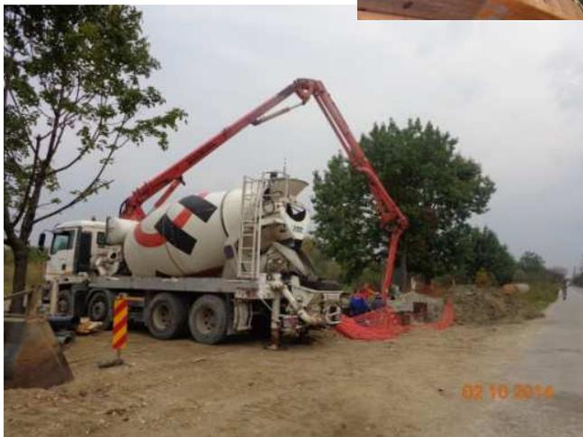
Tras la ejecución de la losa inferior se posiciono la estación de bombeo y se le realizo un anillo perimetral de hormigón anti flotación.
