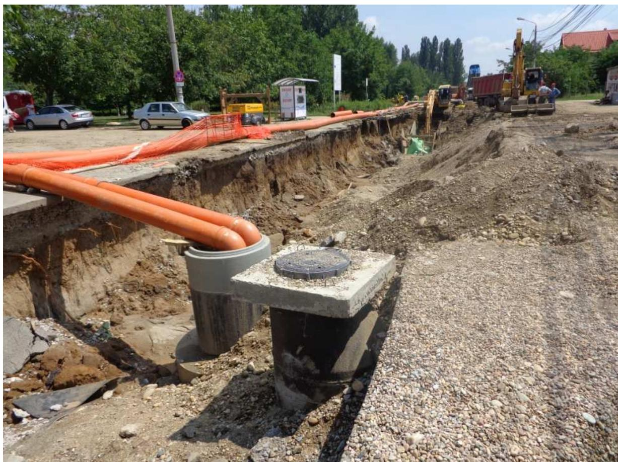
Se añadió el problema de nivel freático que tuvimos que resolver mediante una estación de bombeo con filtros hincados.
