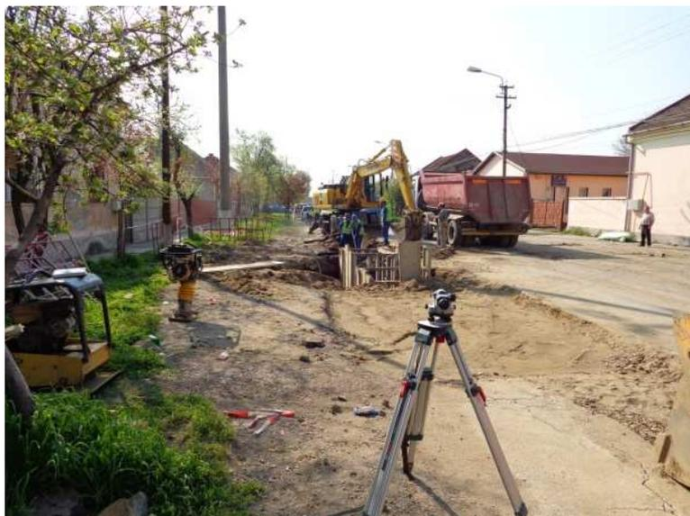
Los trabajos se realizaban de manera continua, realizando las fases de ejecución de manera correlativa, es decir, se realizaba la excavación, se comprobaba la cota, se colocaba un geotextil que envolvía la tubería que estaba rodeada de grava, después se continuaba el relleno de la zanja con tierras o zahorras, para proceder a su compactado.
