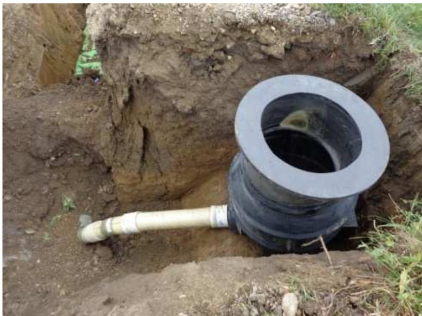
La conexión a las casas se realizaba a traves del pozo de plástico, el cual tiene una pieza de prolongación superior que permite variar la altura del mismo, pudiendo ir desde alturas de 1m hasta alturas de 2,10m. Después de la colocación de este pozo de plástico, la conexión a la canalización existente se hacía o bien directamente a la tubería mediante pieza especial tipo T o bien directamente al pozo prefabricado de hormigón, en los casos en los que el este, este enfrentado al pozo de plástico.
