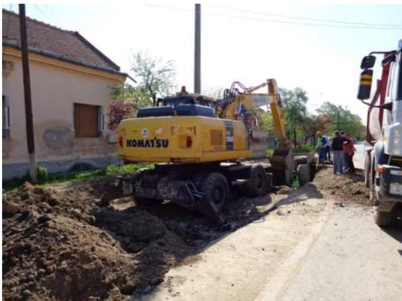
Para realizar las conexiones de las tuberías que vienen de las casas y van directas a la tubería principal se realizaba mediante la perforación de la misma y colocación de una pieza especial en forma de "T" la cual se fijaba mecánicamente, asegurando así la estanqueidad.
