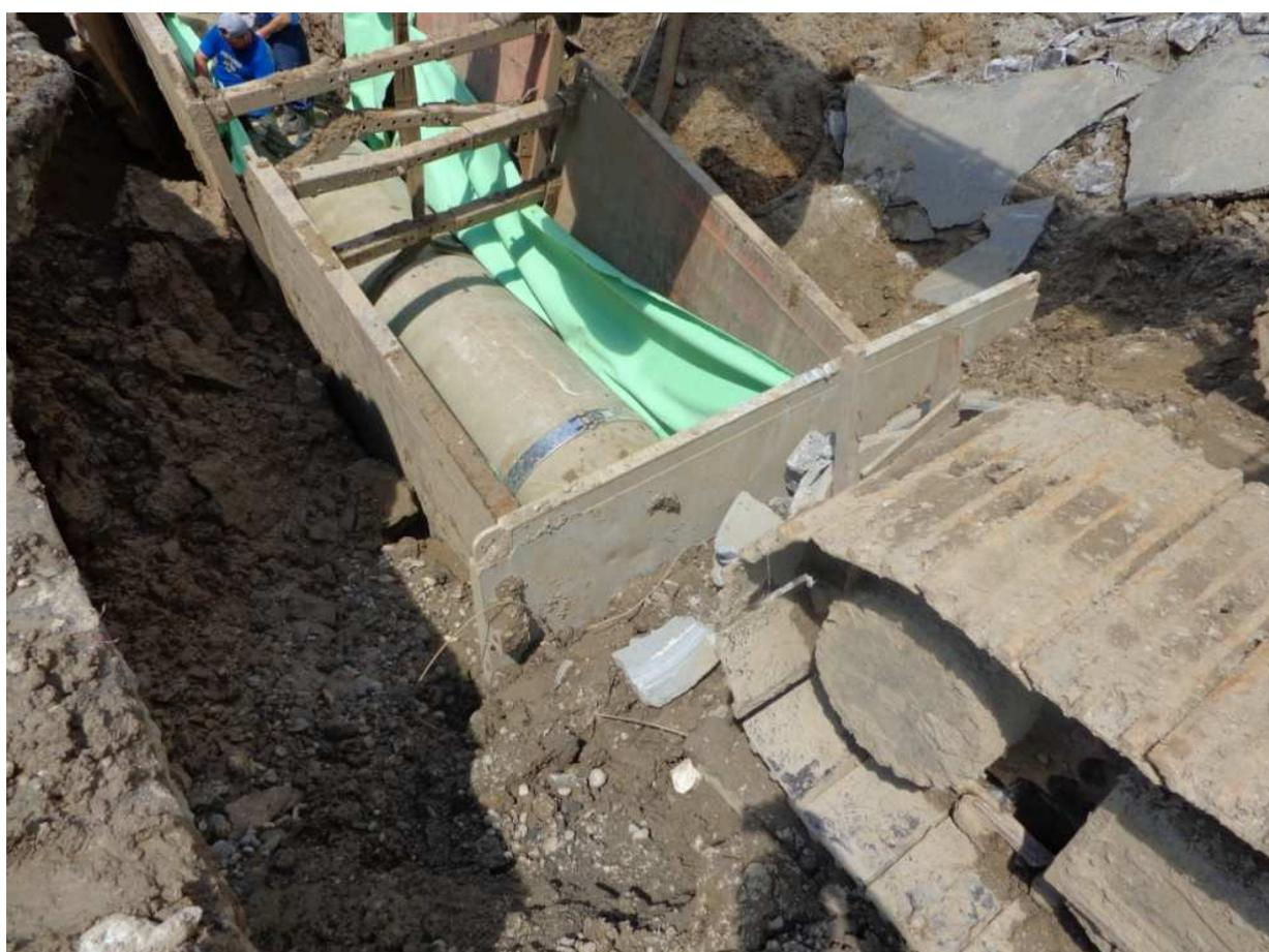
Se ataludo la excavación y en la zona donde se instalaba la tubería se colocaba la entibación. Fue la única manera de conseguir avanzar con los trabajos y darles una buena seguridad en el tajo a los trabajadores, aunque eso supusiese tener que rehacer mucha más superficie.
