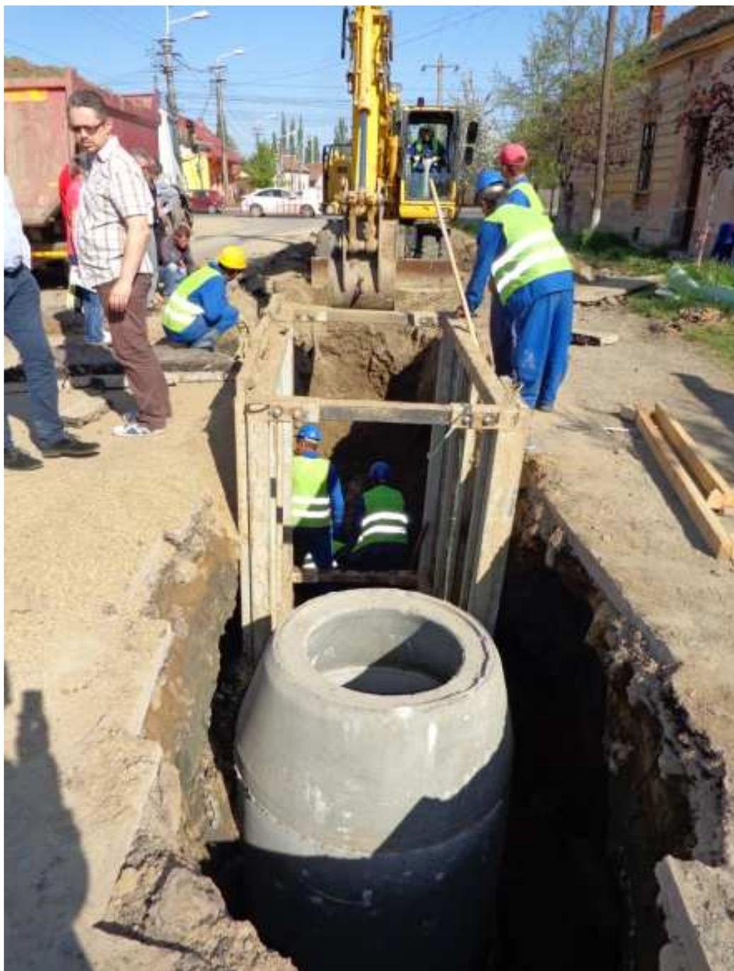
El material utilizado para la realización de los pozos venía con las propias piezas de paso embebidas en la base prefabricada de hormigón lo cual garantiza la estanqueidad de la instalación.
