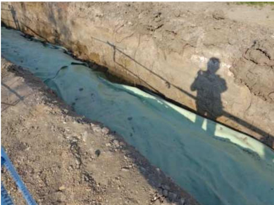
La grava que se colocaba alrededor de la tubería y envuelta en geotextil era comprobado aleatoriamente por la Dirección Facultativa.
