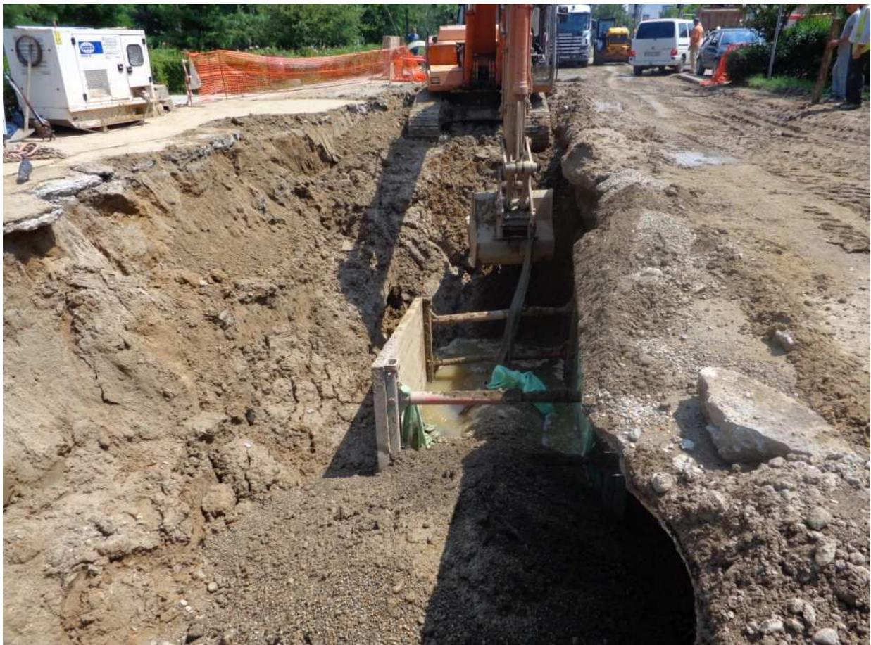
En la calle citada anteriormente tuvimos el problema añadido de tener que estar bombeando constantemente el caudal proveniente de la tubería existente, es por esto que debimos de realizar un bypass para asegurar que la zona de trabajo estaba exenta de aguas fecales.
