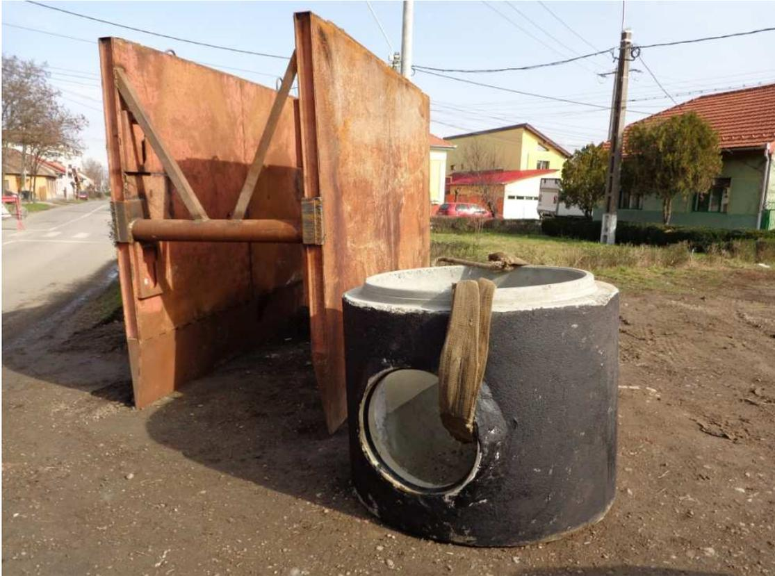
En una de las calles de ejecución tuvimos el problema que el terreno era muy arenoso y no conseguíamos contener las tierras mediante las entibaciones por lo que se optó por una solución diferente en la ejecución, se realizó una solución mixta de excavación a cielo abierto en la parte superior y de entibar la zona de instalación de la tubería para proteger a los trabajadores.
