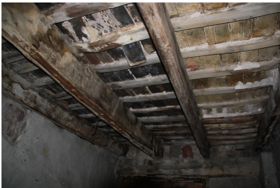
Imagen 86. Cubierta altillo 1 (Fuente propia)
