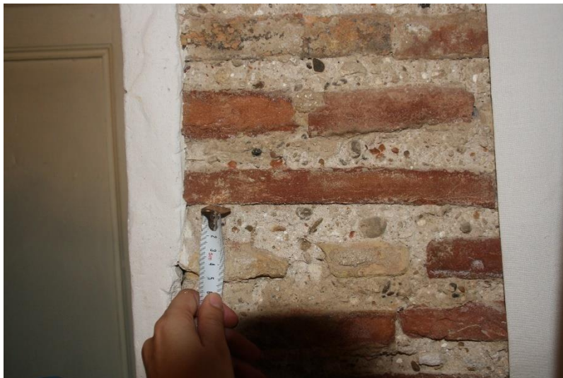
Imagen 37. Muro de carga planta baja (Fuente propia)
