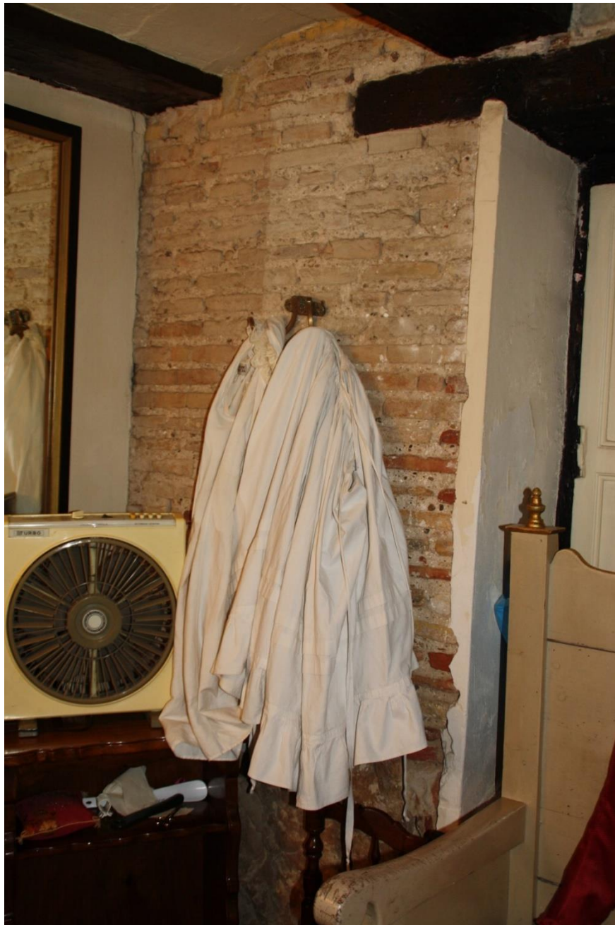
Imagen 74. Muro planta baja (Fuente propia)
