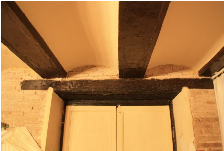
Imagen 79. Dintel de Planta baja (Fuente propia)
