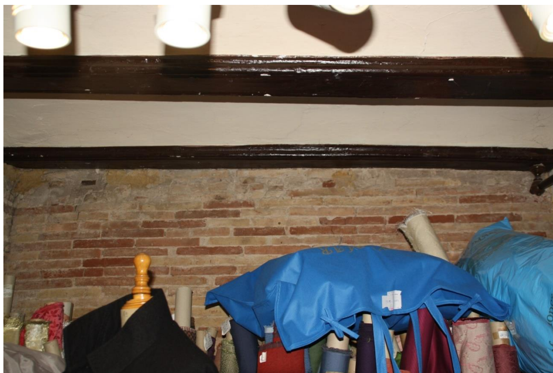
Imagen 75. Muro planta baja
