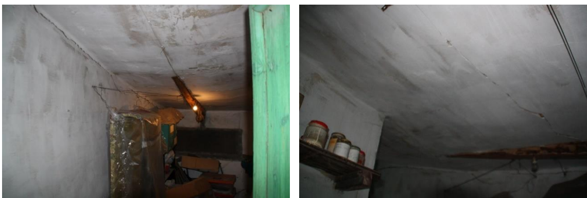
Imagen 87. Cubierta altillo 2 (Fuente propia)
