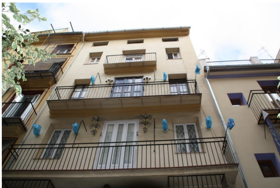
Imagen 76. Voladizos (Fuente propia)
