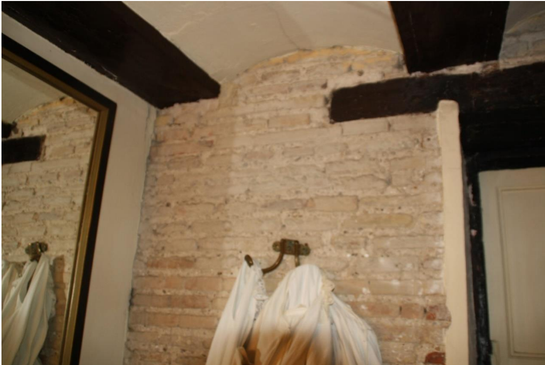
Imagen 44. Muro de carga Planta baja (Fuente propia)
