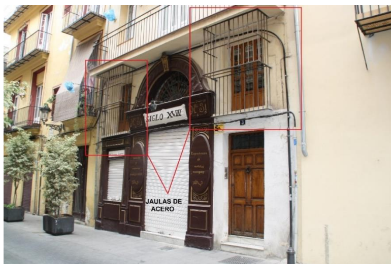
Imagen 66. Elementos de protección 1 (Fuente propia)
