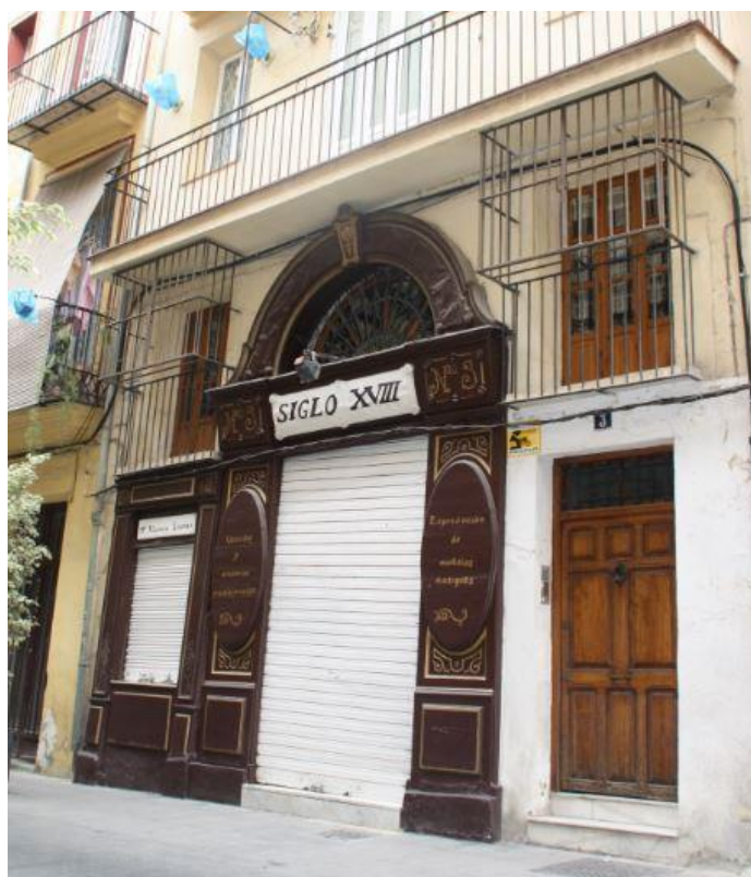
Imagen 25. Fachada c/Avellanas (Fuente propia)
