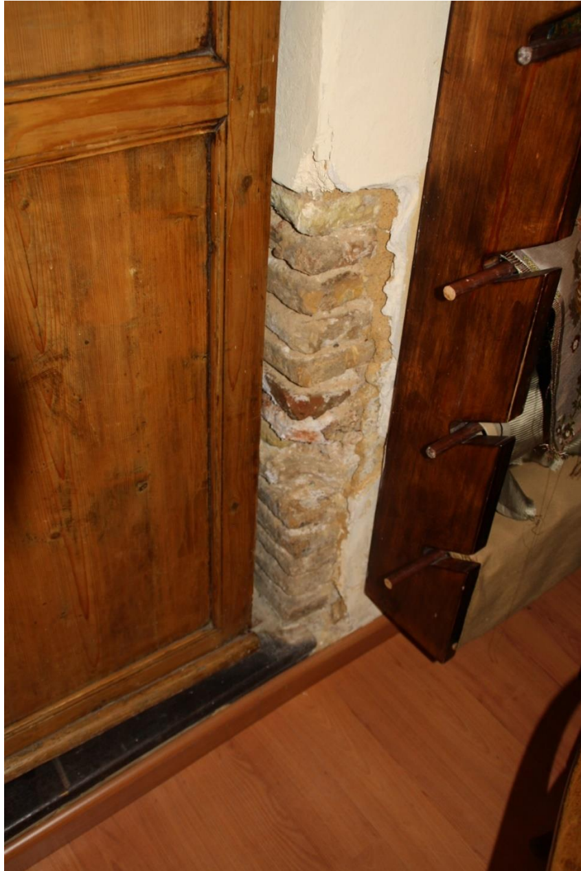
Imagen 73. Muro de la planta baja (Fuente propia)
