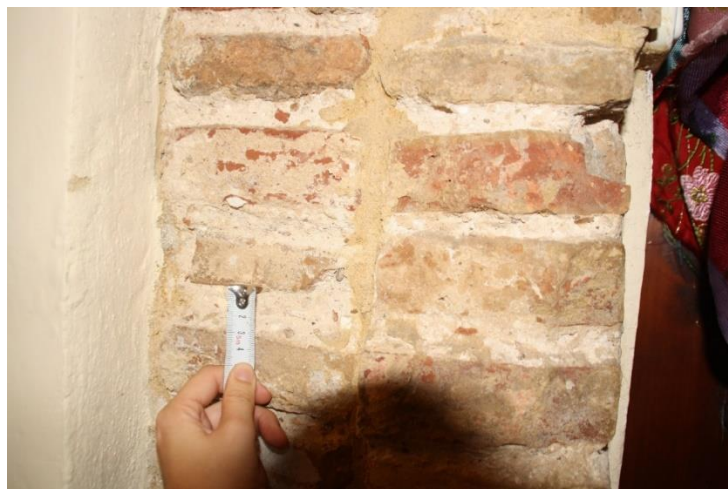
Imagen 72. Muro de planta baja (Fuente propia)
