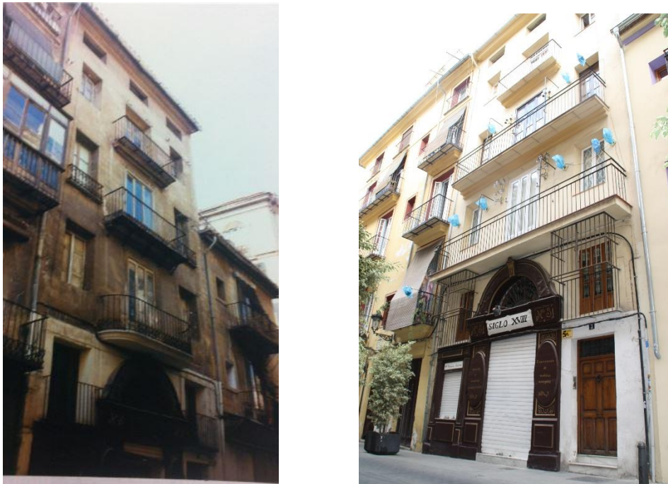
Imagen 31. Fachada c/Avellanas, antes y después de la reforma (Fuente propia)
