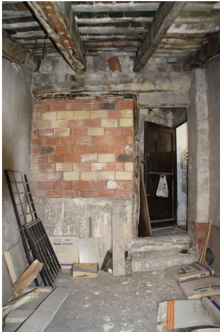
Imagen 85. Cubierta atillo 1 (Fuente propia)
