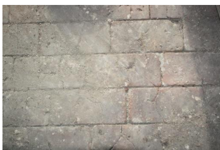
Imagen 60. Pavimento altillo 1 (Fuente propia)
